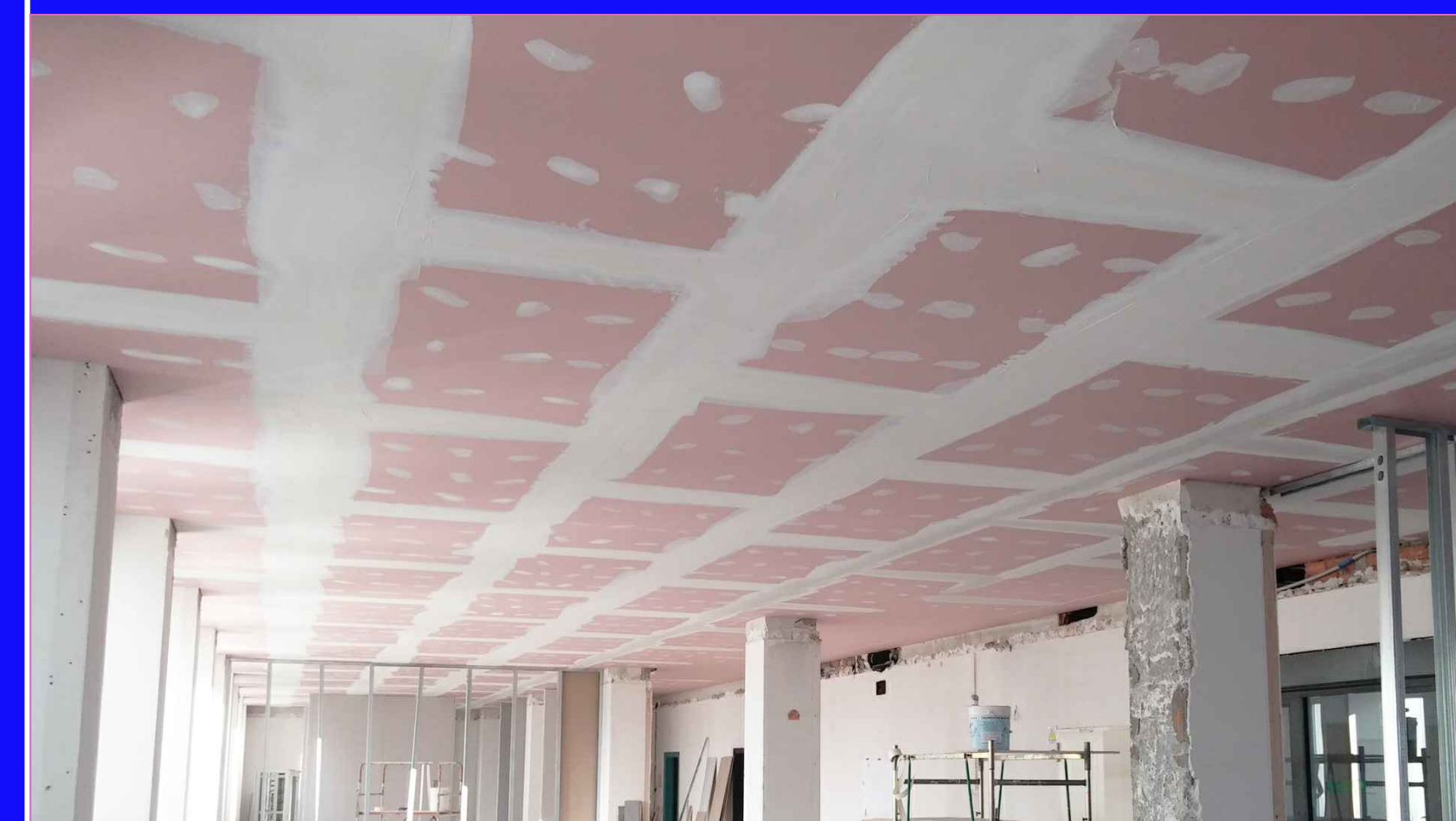
Dettaglio installativo REI 120
