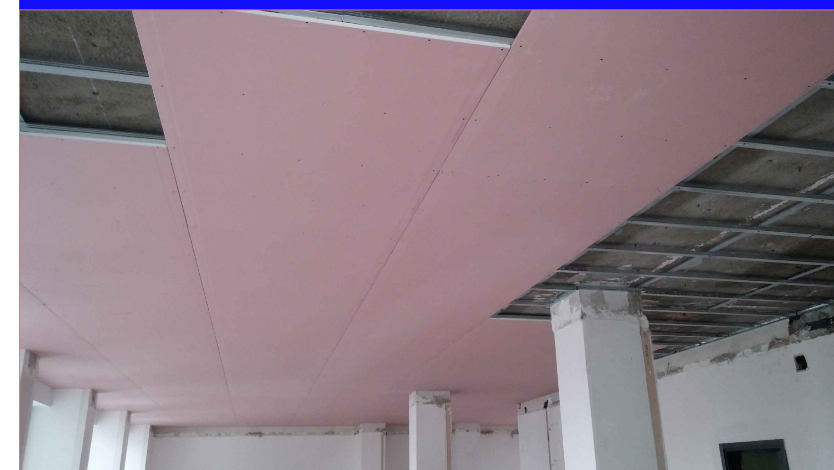
Dettaglio installativo REI 120
