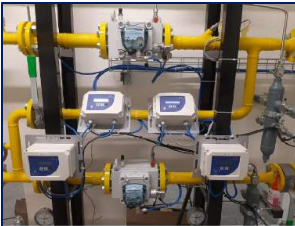
Figura 16 Particolare della componente di misura volumetrica
