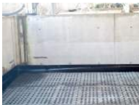
Fig. 2 Posizionamento Guaina
