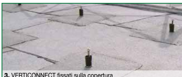
3. VERTICONNECT fissati sulla copertura
