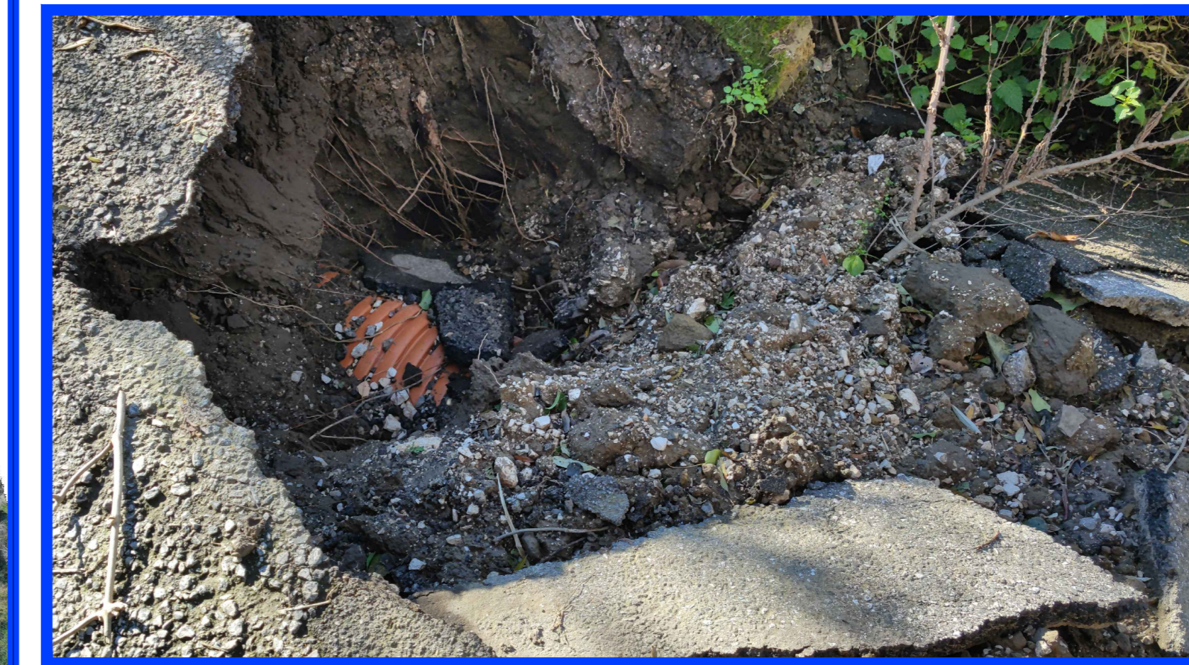
Sprofondamento strada via Cupa Camaldoli con fognatura a vista
