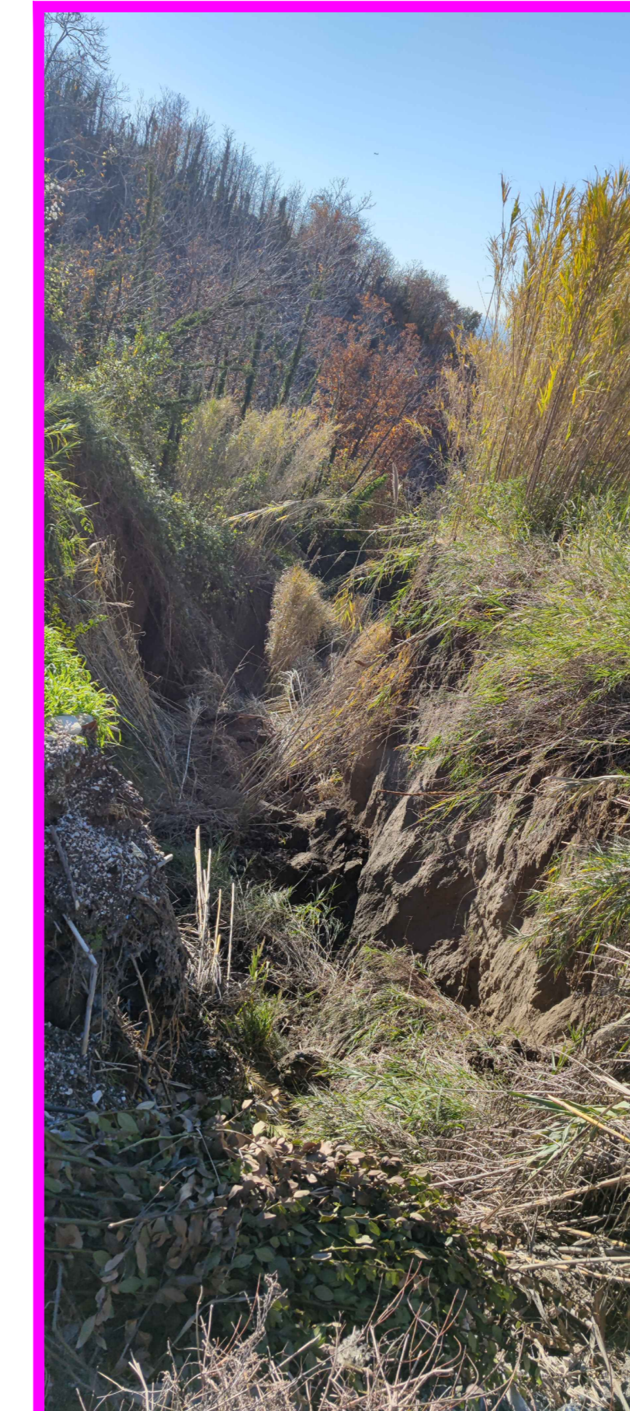
Forte erosione alveo Varchetta
