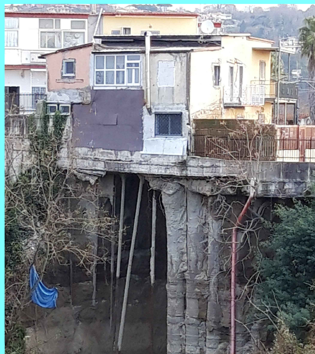
Paratia di pali completamente a nudo
