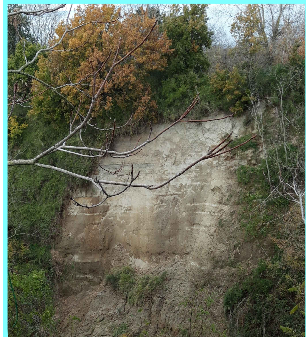
Frana versante in dx idraulica
