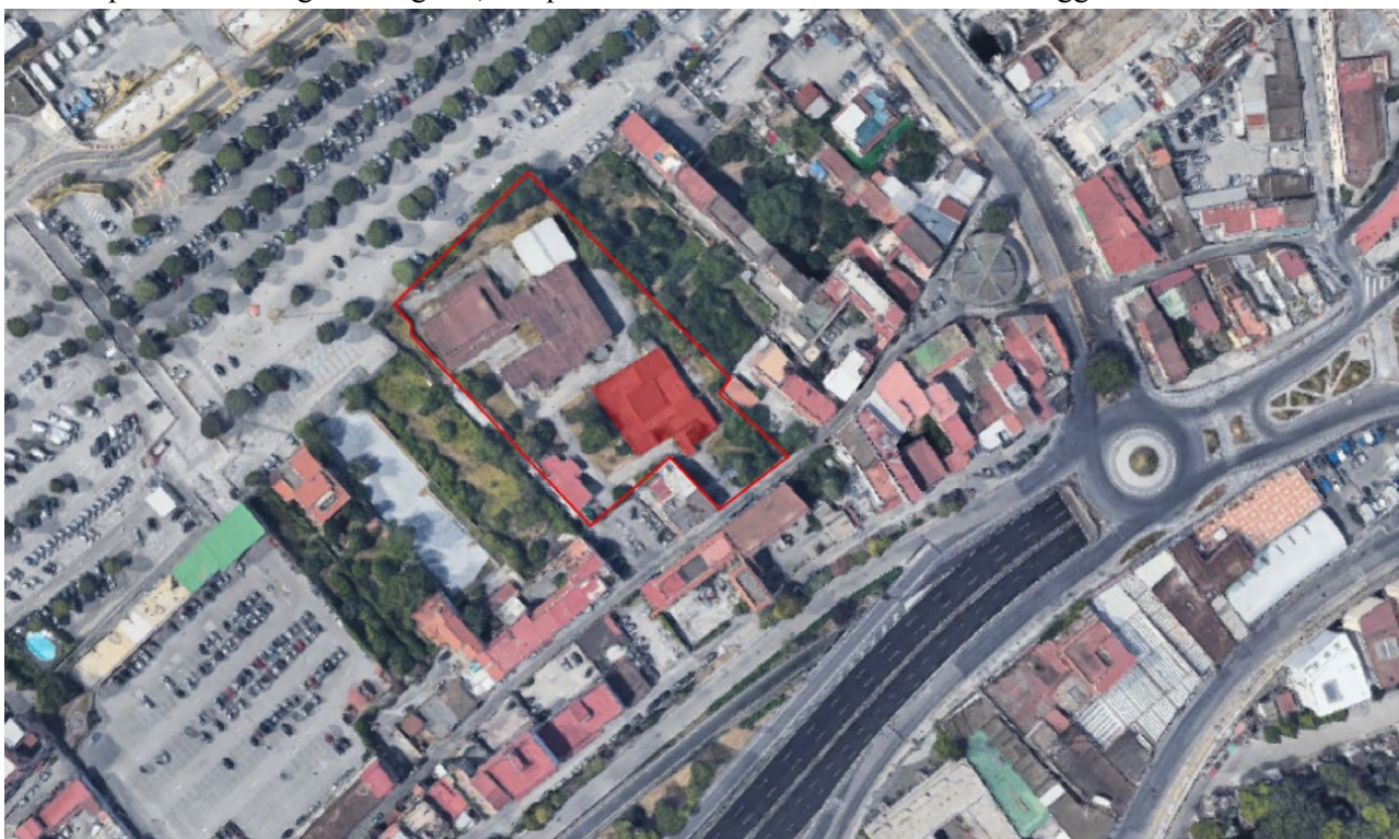
Figura 1 – Inquadramento dell'edificio oggetto di studio di fattibilità tecnico ed economico
