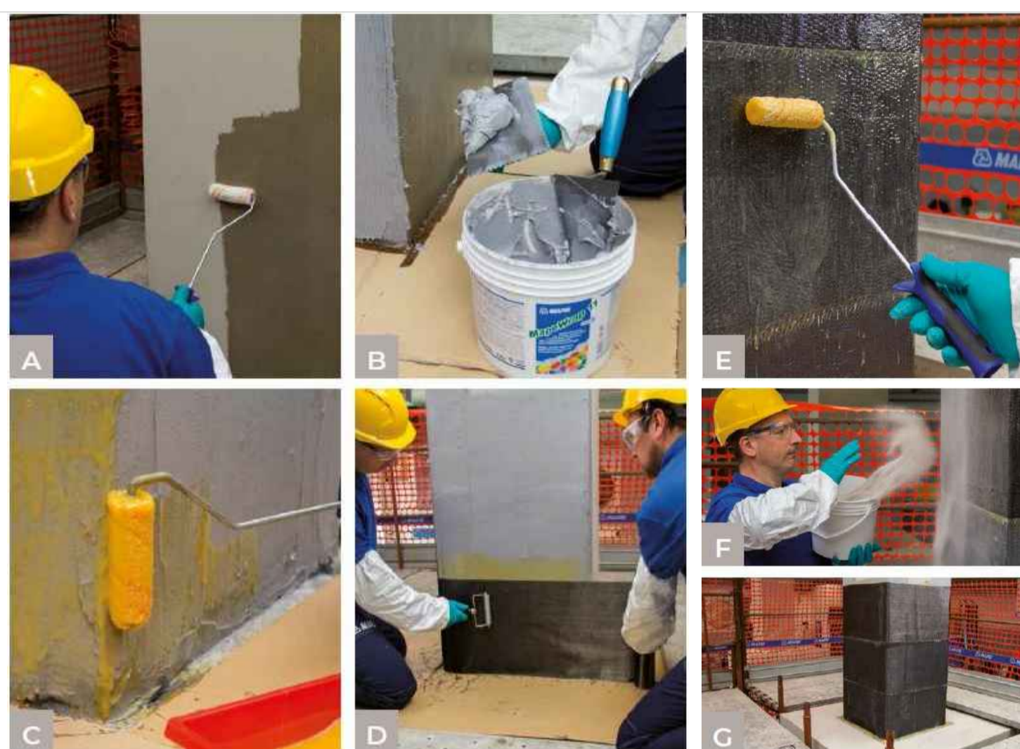
Rinforzo travi e pilastri con FRP
