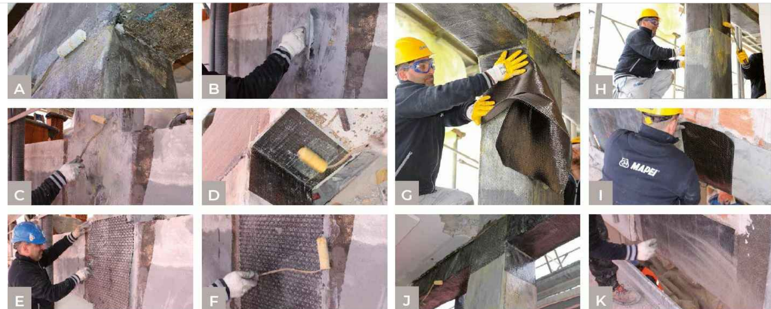
Rinforzo travi e pilastri con FRP
