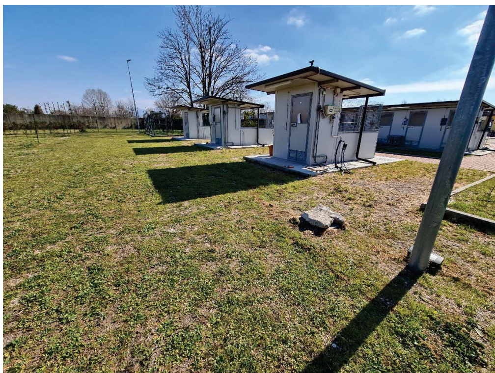
IMMAGINE 8: VISTA DELLE STRUTTURE DEL CANILE CONFINE LATO EST AREA D'INTERVENTO
