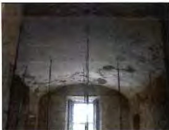
Prova n. 4: particolare dell'ubicazione dei sensori e tipologia dell'elemento testato.
