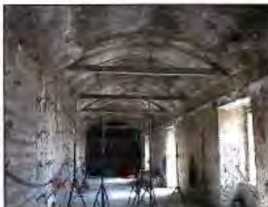
Prova n. 1: particolare dell'ubicazione dei sensori.
