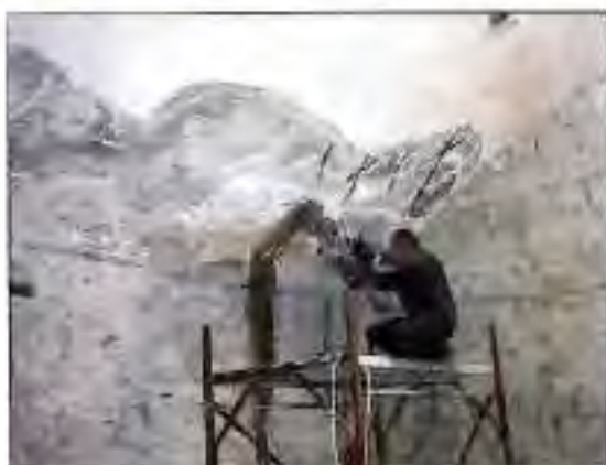
Particolare del prelievo di carote in cls, volta livello 6.
