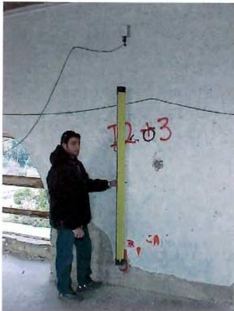
Corrispondenza dei capisaldi di livellazione con gli inclinometri
