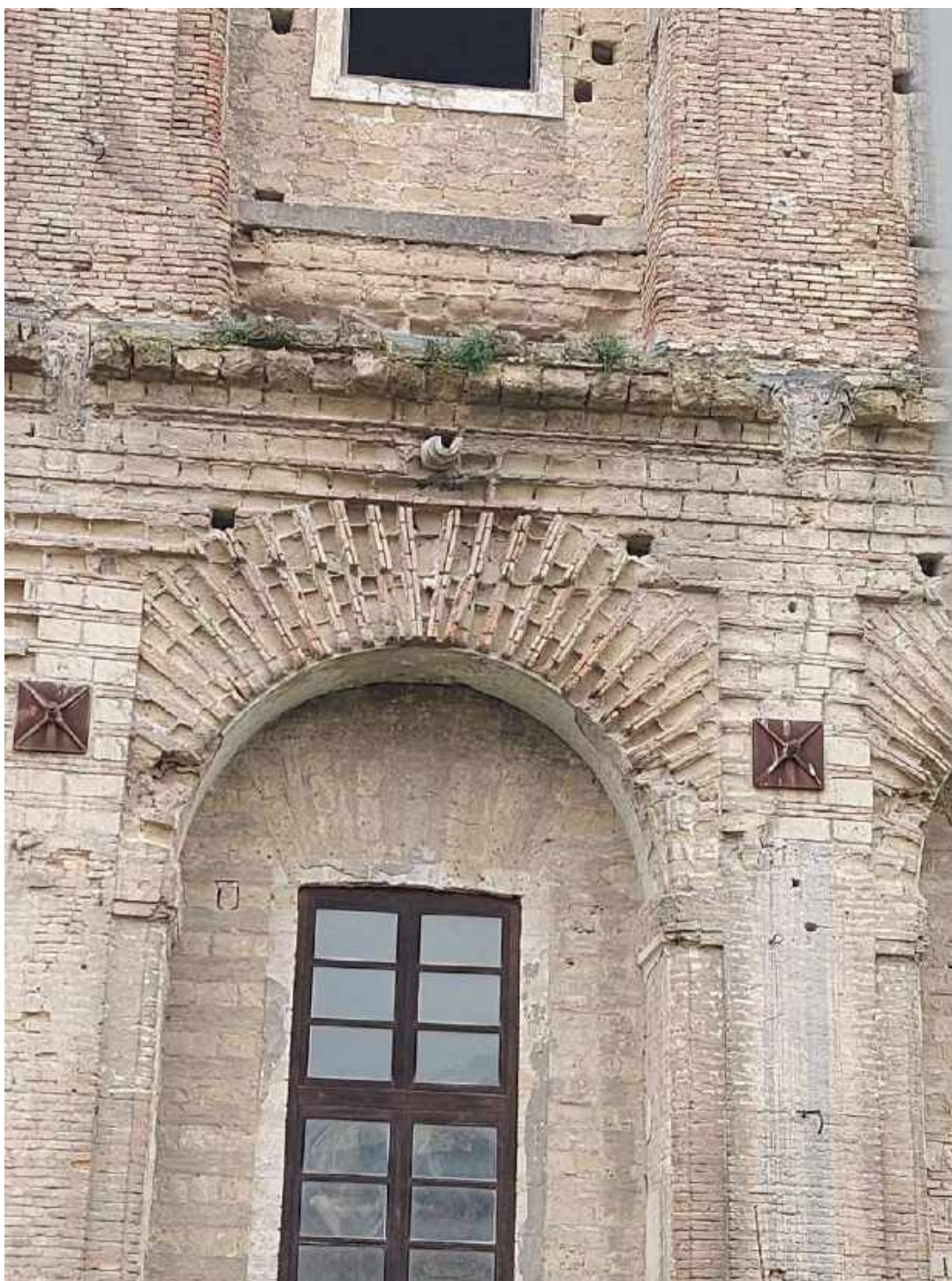
Murature listate presenti sui prospetti esterni
