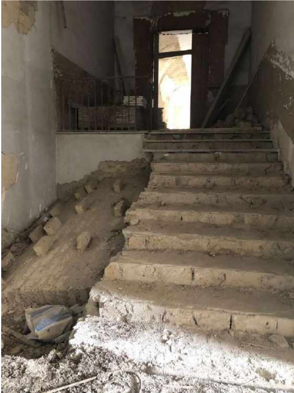
Una scala parzialmente demolita al terzo livello
