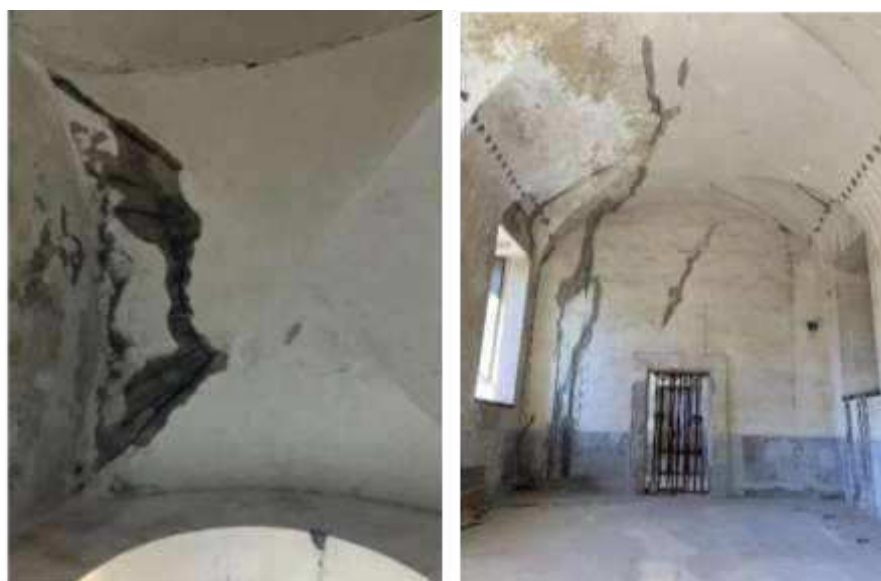
Figura 25 Individuazione delle volte in c.a.
