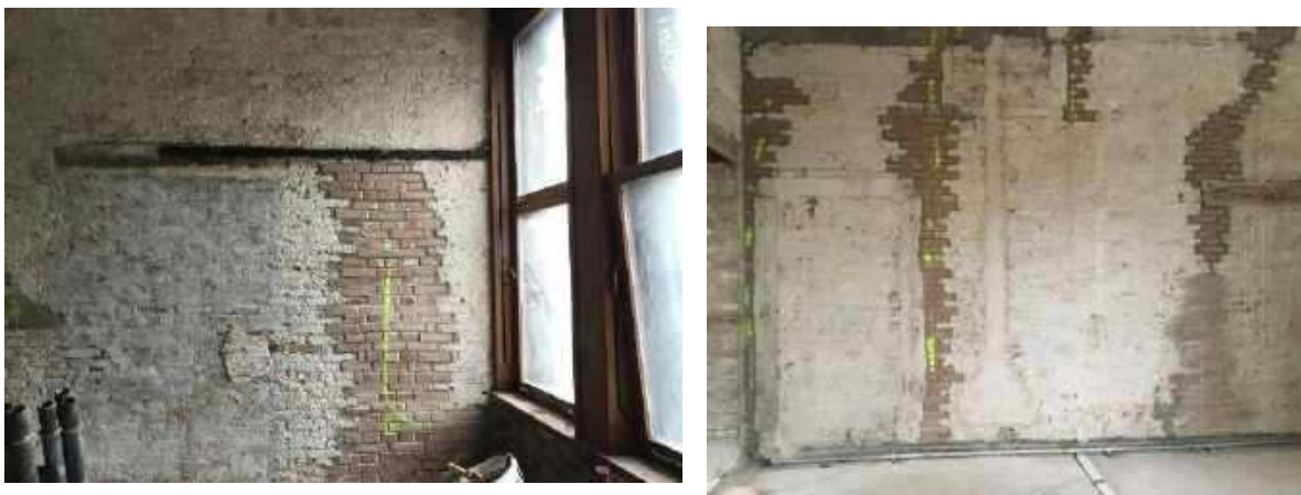
Figura 11 Esempio di interventi di scuci e cuci effettuati per la riparazione delle murature
