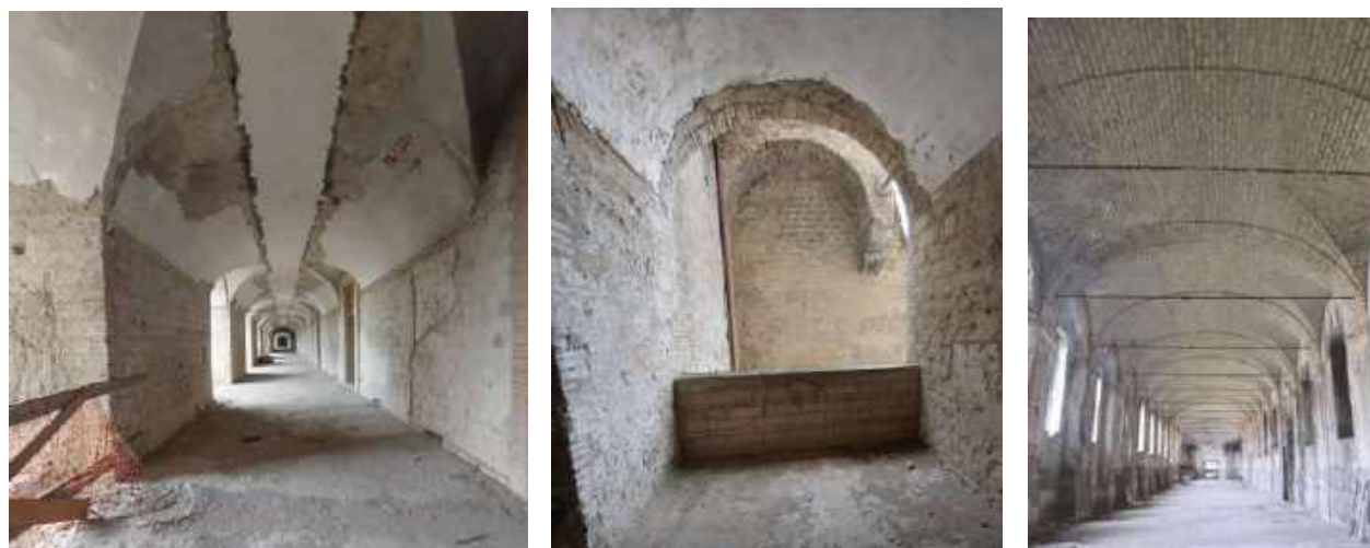
Da sin: Volte in tufo rinforzate con l'applicazione di fibre aramidiche in mezzeria, volte in tufo intonacate, Volte in tufo con catene di rinforzo in ferro.
