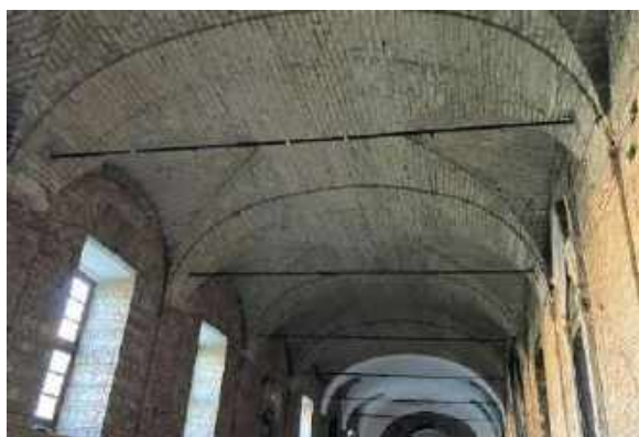
Figura 23: Individuazione delle volte in muratura di tufo
