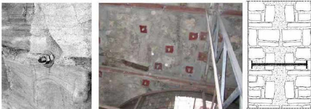
Figura 17: Esempi di applicazione di tiranti antiespulsivi, con rondella, piastra di piccole dimensioni e ancoraggio non a vista [2]
