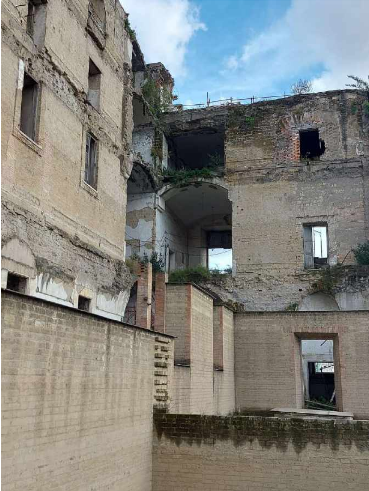
Il volume in muratura aggiunto nei livelli basamentali del corpo C5
