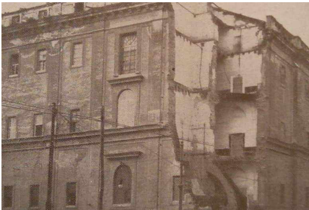
Il crollo del cantonale sud-est negli anni Venti del Novecento. Da Napoli. Le opere del Regime, 1930.
