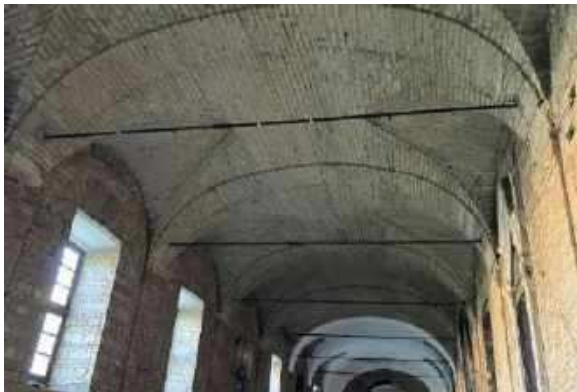
Figura 7: Individuazione delle volte in muratura di tufo
