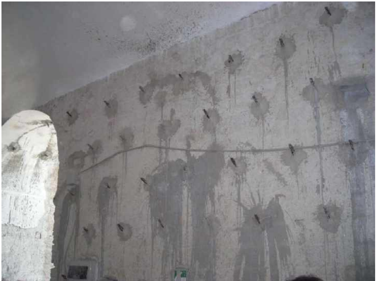
Murature integrate in progressi interventi con iniezioni armate
