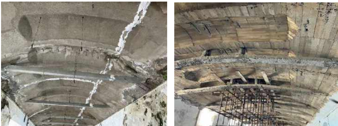
Figura 28: Individuazione delle volte in c.a., differenti per tipologia di costruzione da quelle individuate come di tipo 2.
