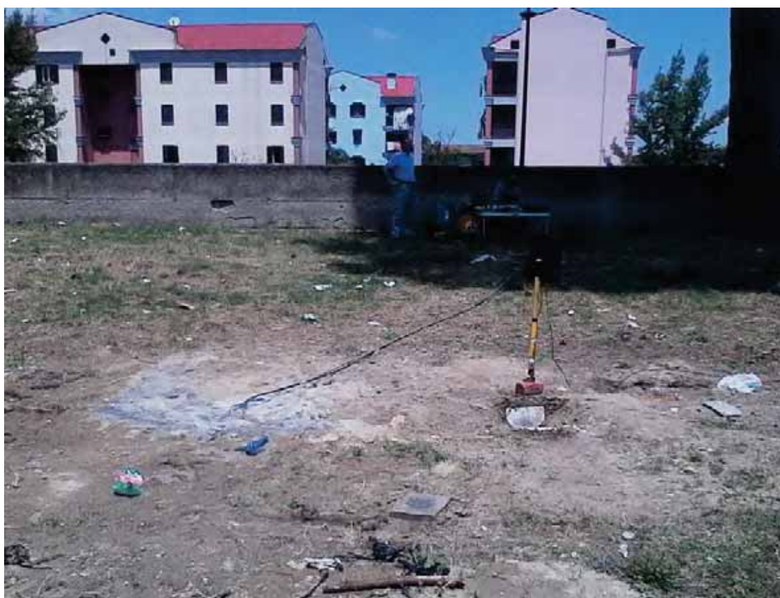
Foto Down Hole
