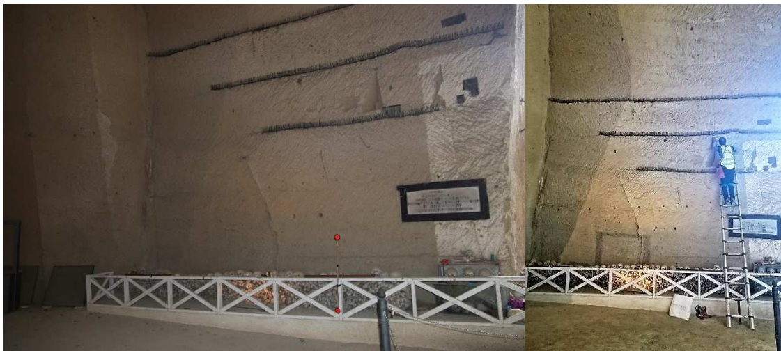
Figura 22. Parete della “Navata dei Pezzentelli” interessata da un diffuso quadro fessurativo (a sinistra) e operazioni di installazione di fessurimetri planari (a destra).
