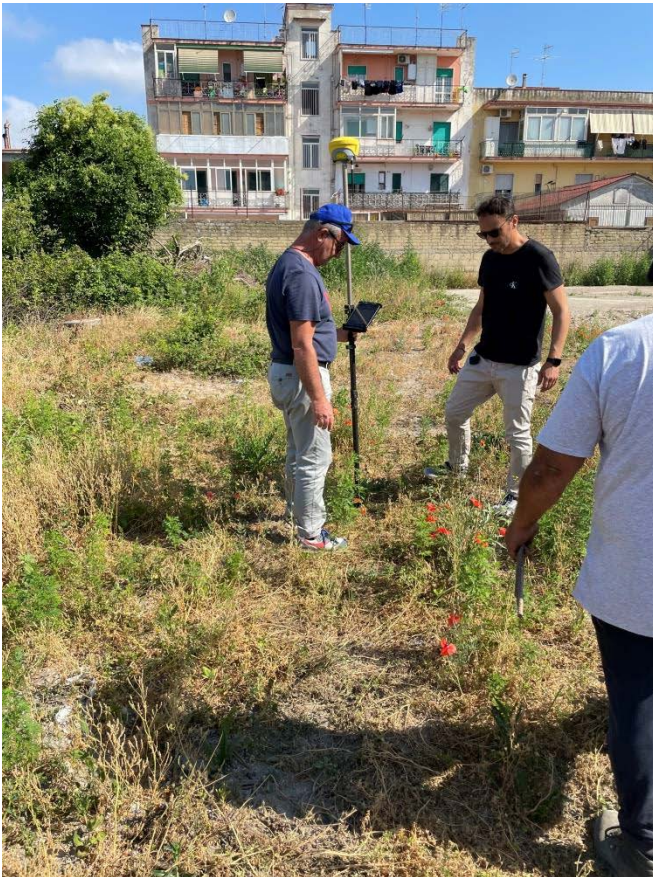
Fig.2 - Operazioni di picchettamento dei punti di indagine.
