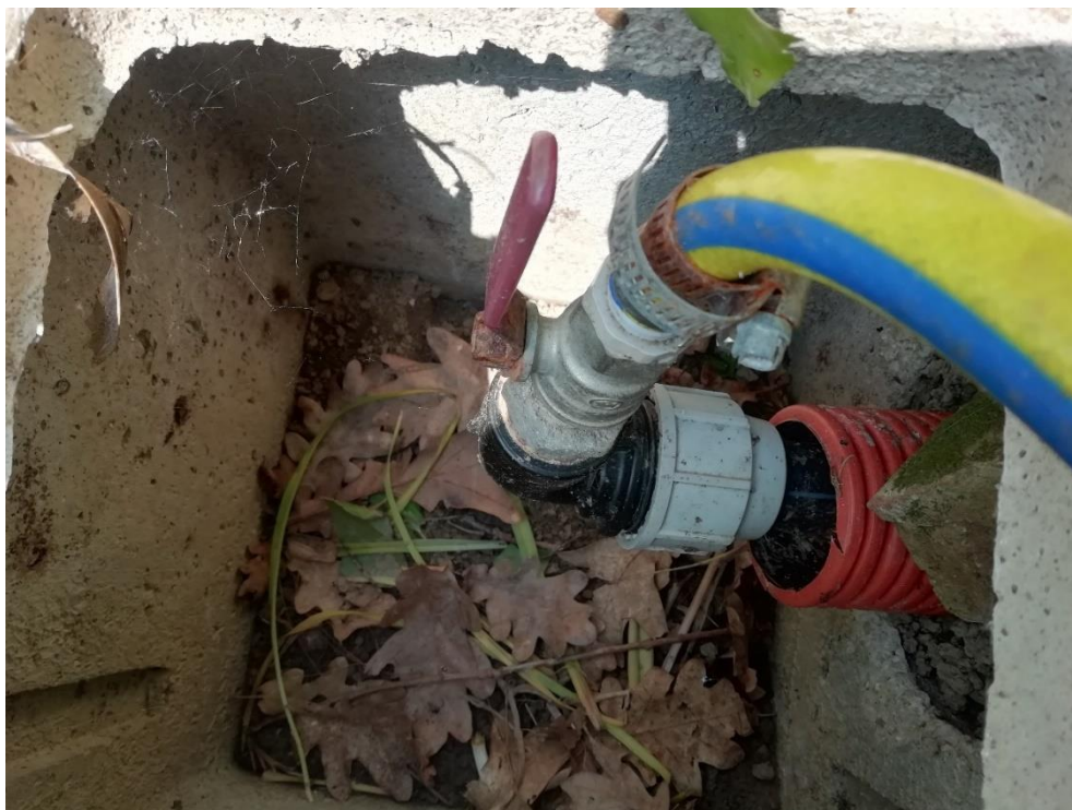
Foto N. 2 Particolare dell'attacco di raccordo con saracinesca per l'irrigazione dinamica manuale.
