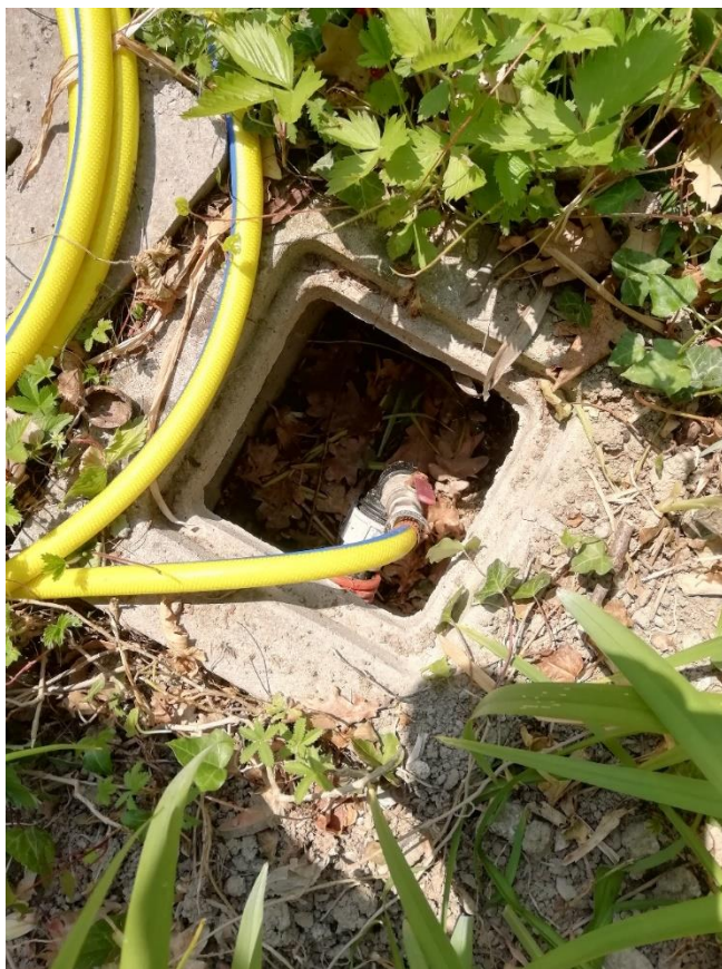
Foto N. 1 Particolare di pozzetto per irrigazione dinamica manuale
