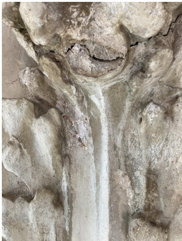
Foto 11 Particolare di un capitello, fratturazioni e perdita di materiale
