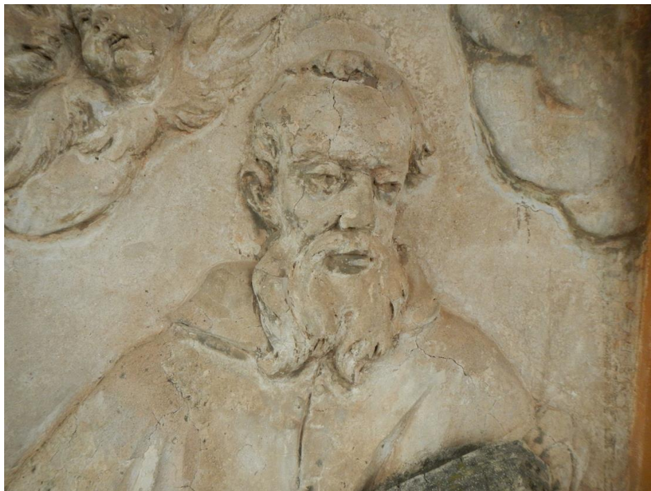
Foto 5 Bassorilievo secondo ordine raffigurante S. Francesco, macchie nere di natura biologica, stuccature di restauro e scialbi colorati, microlesioni diffuse e mancanze di materia
