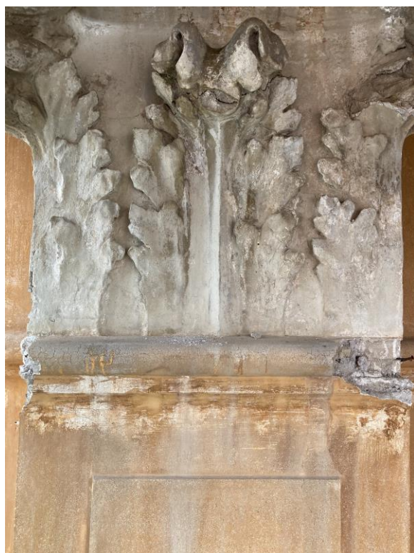
Foto 10 Capitelli in stucco, croste nere, patine biologiche, fratturazioni e perdita di materia
