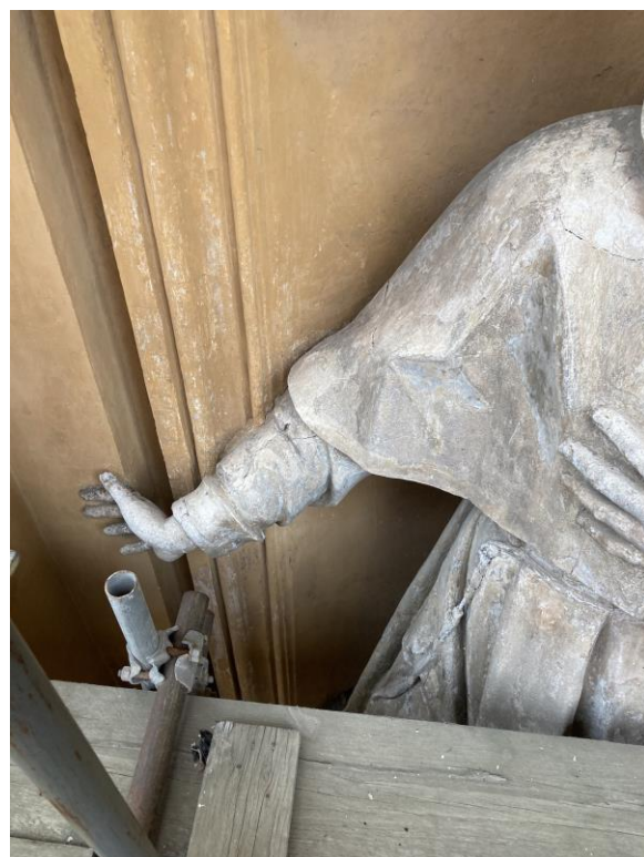
Foto 8 Scultura primo ordine raffigurante S.Francesco, macchie nere di natura biologica, stuccature di restauro e scialbi colorati, microlesioni diffuse e mancanze di materia.
