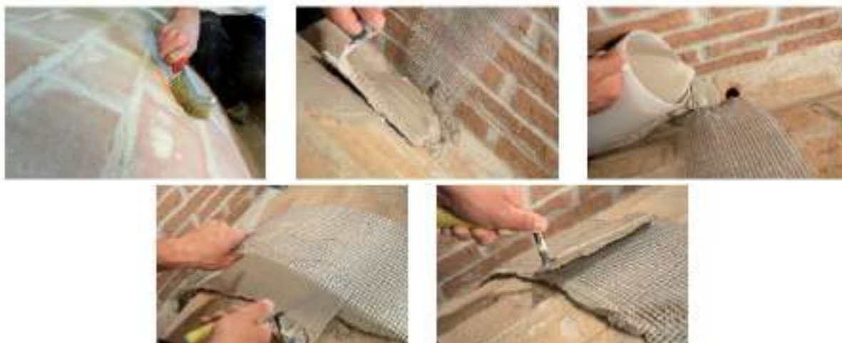
Figura 1 - Fasi lavorative di posa in opera dei tessuti in fibra di acciaio
