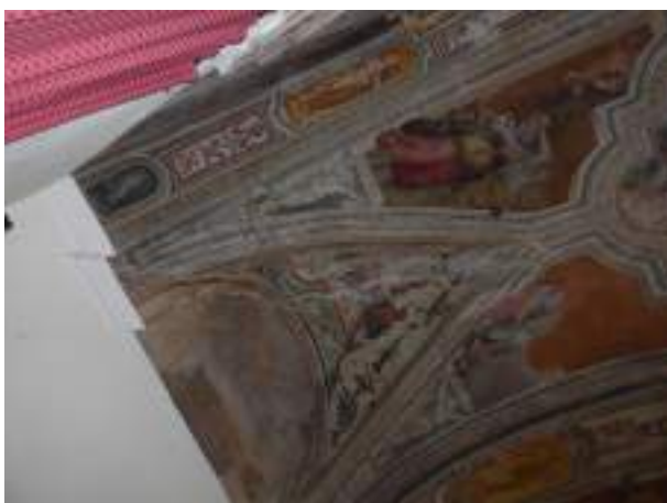
Le foto mostrano le lesioni hanno andamento subverticale e inclinato e si sviluppano anche lungo la direttrice della volta della Sala Sisto V.
