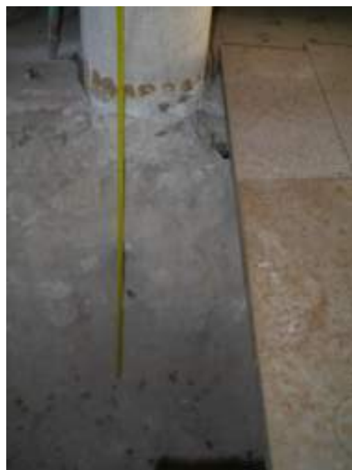
Le foto mostrano le lesioni hanno andamento subverticale e inclinato e si sviluppano anche lungo la direttrice della volta della Sala Sisto V.
