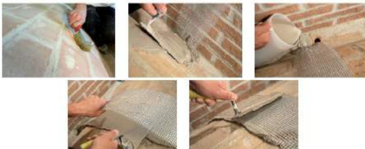
a) Figura 2 - Fasi lavorative di posa in opera dei tessuti in fibra di acciaio
