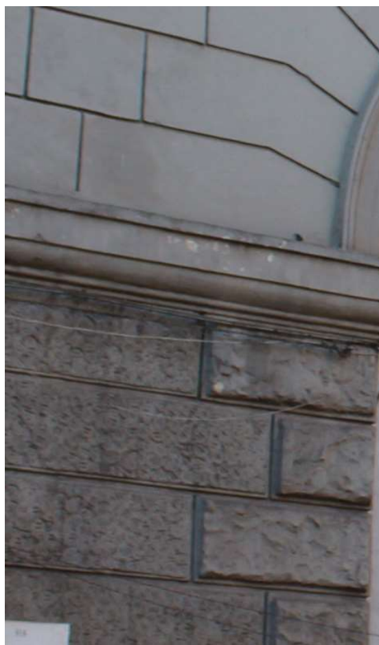
Figura 1 - Tipologie di intonaci bugnati
