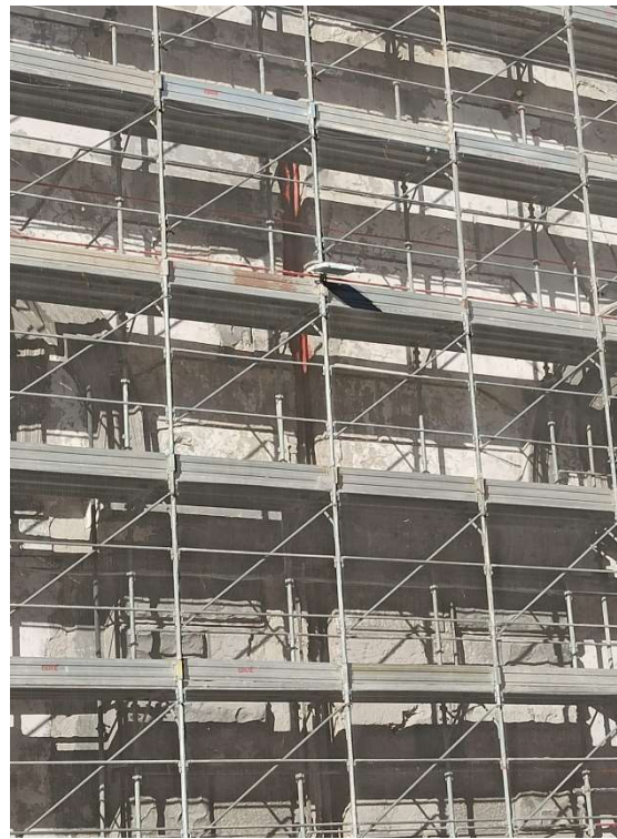
Figura 4 - Pluviali in cemento amianto
