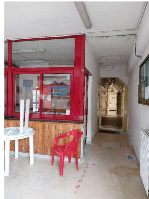
Vista interna all'impianto natatorio indoor
