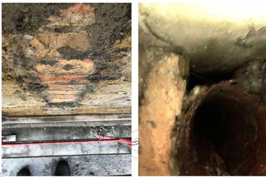
RILIEVO FOTOGRAFICO SOPRALLUOGO IN DATA 11 02 2022
