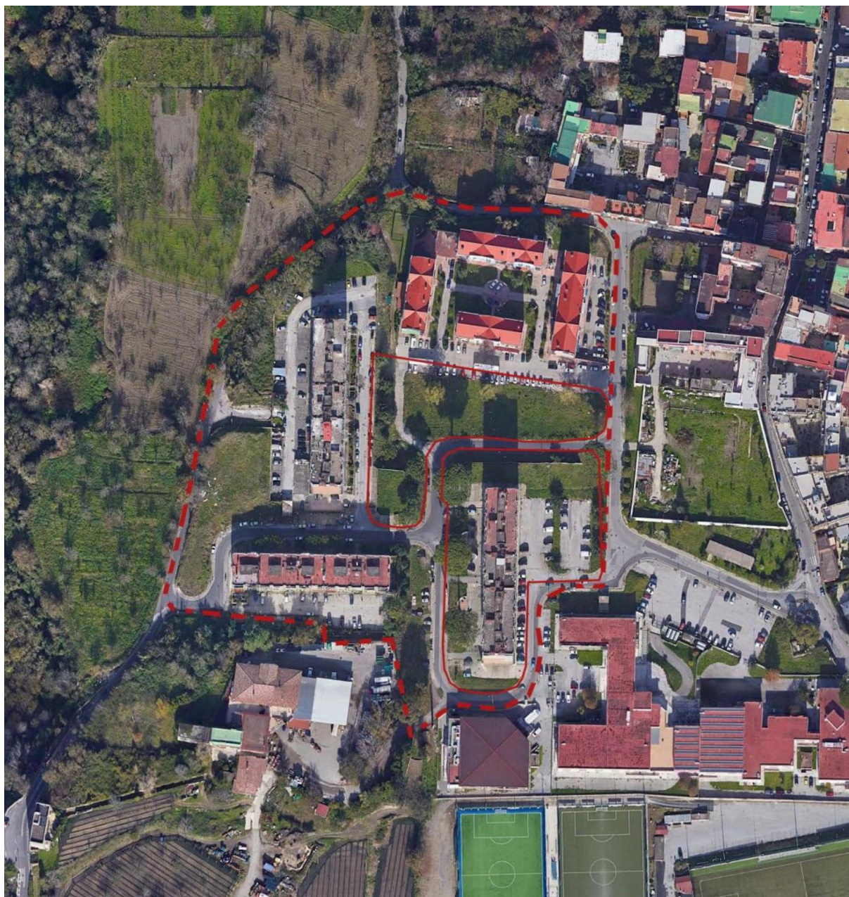
Fig. 2 - Ambito di e.r.p. di via Toscanella, con i 3 prefabbricati e, a nord, la corte con i 4 edifici che hanno sostituito l'unico prefabbricato ad oggi demolito nell'ambito della prima fase del Programma di Edilizia abitativa sostitutiva detta "di innesco"
