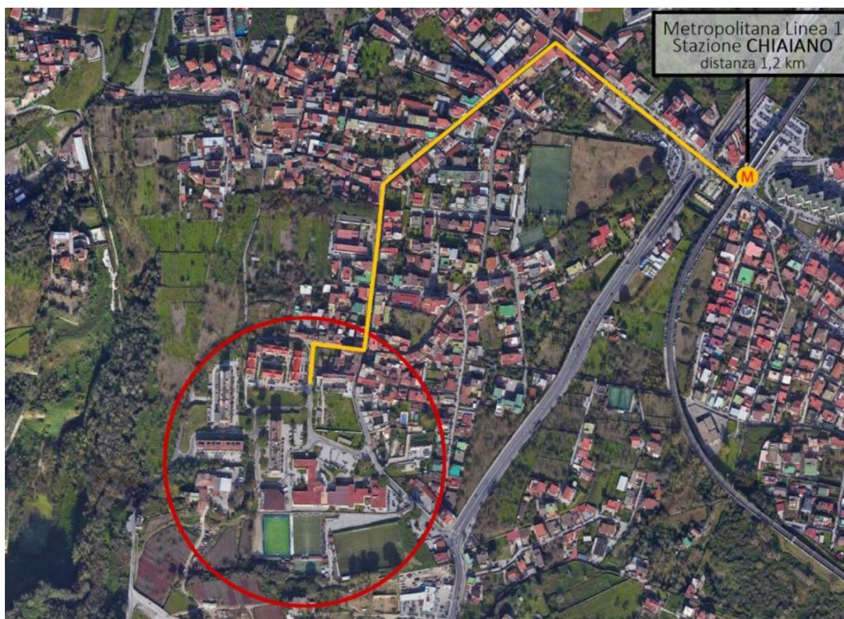
Fig. 1 - Ambito di interesse. Insediamento di edilizia residenziale pubblica di via Toscanella, in relazione al quartiere Chiaiano e alla stazione della metropolitana linea 1.
