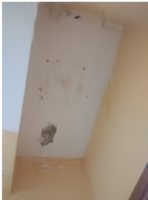
Figura 15: solai ingresso sala attività
