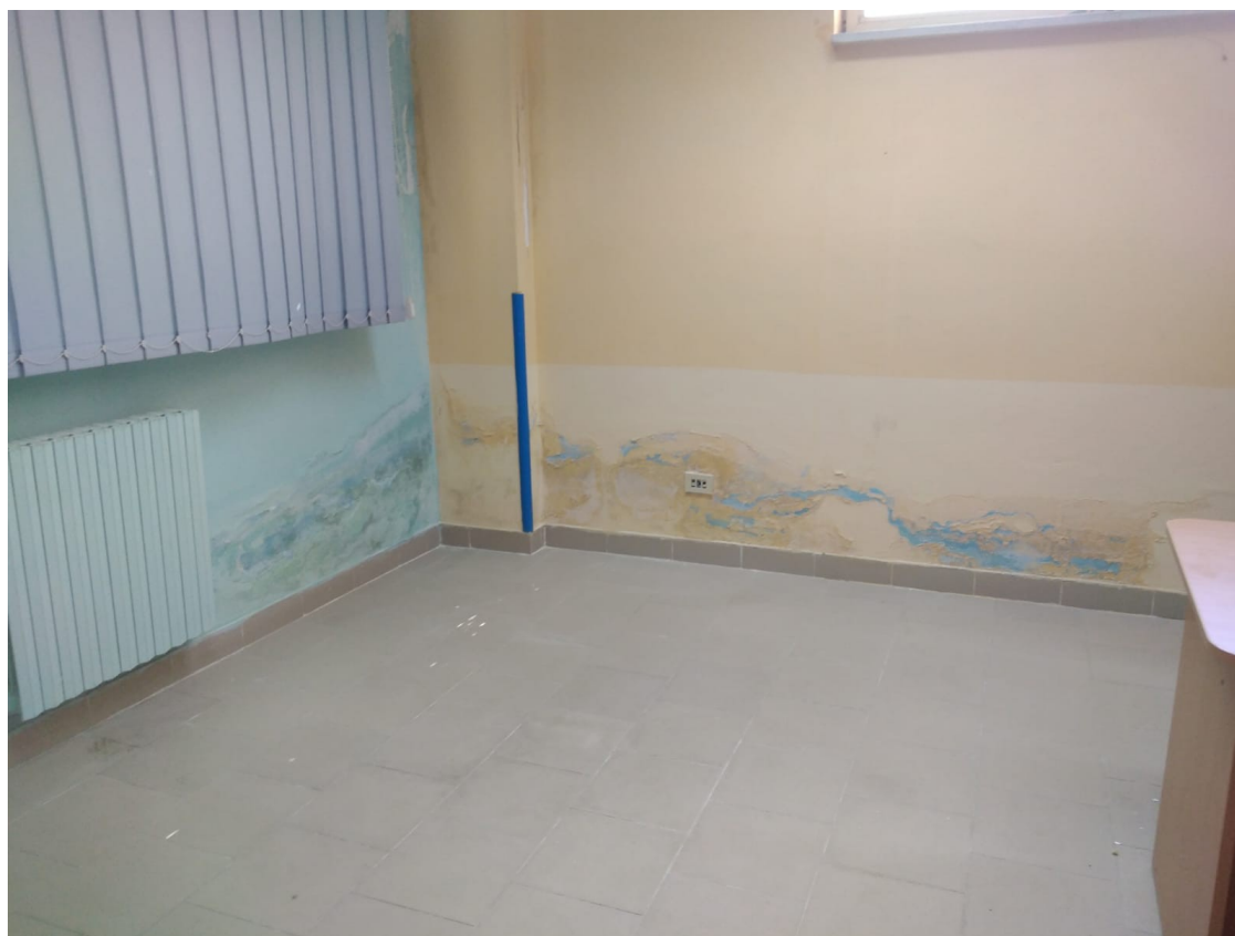
Figura 3: pareti del locale spogliatoio
