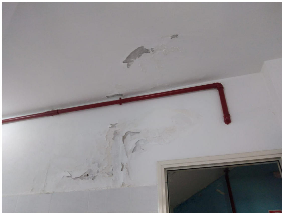
Figura 17: parete e solai del locale bagno - zona ingresso
