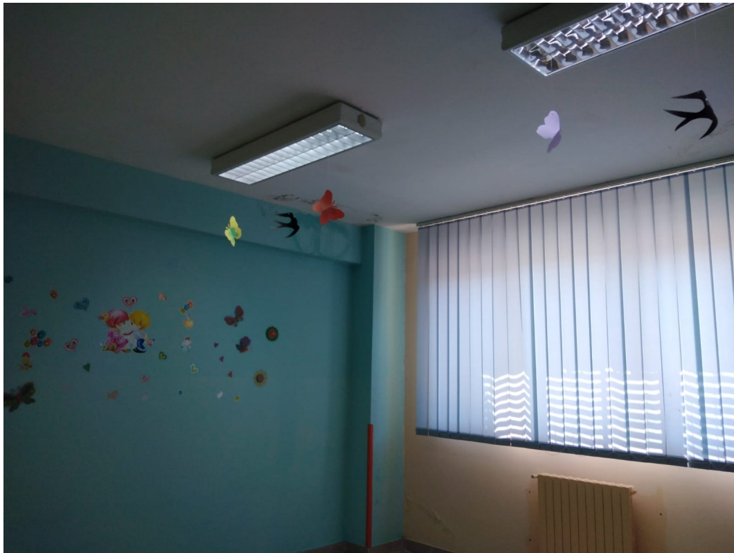
Figura 6: solaio del locale segreteria
