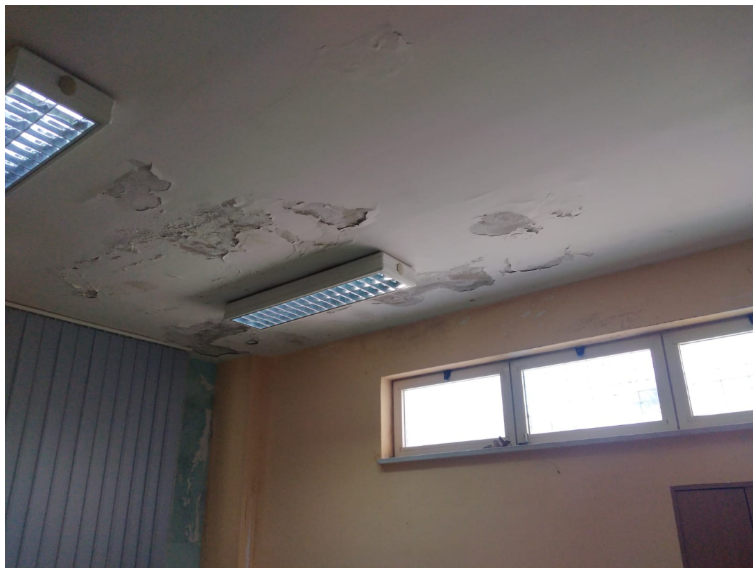
Figura 2: solaio del locale spogliatoio
