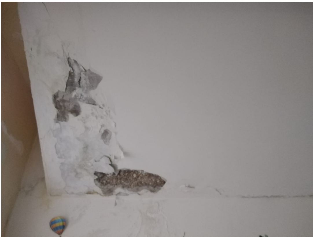
Figura 13: solaio del sottoscale - zona ingresso bagni
