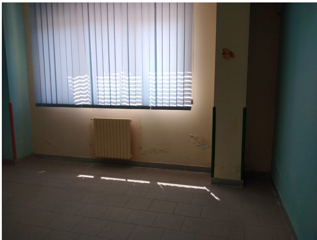
Figura 5: parete del locale segreteria
