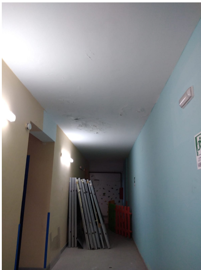
Figura 14: solaio corridoi aule e bagno
