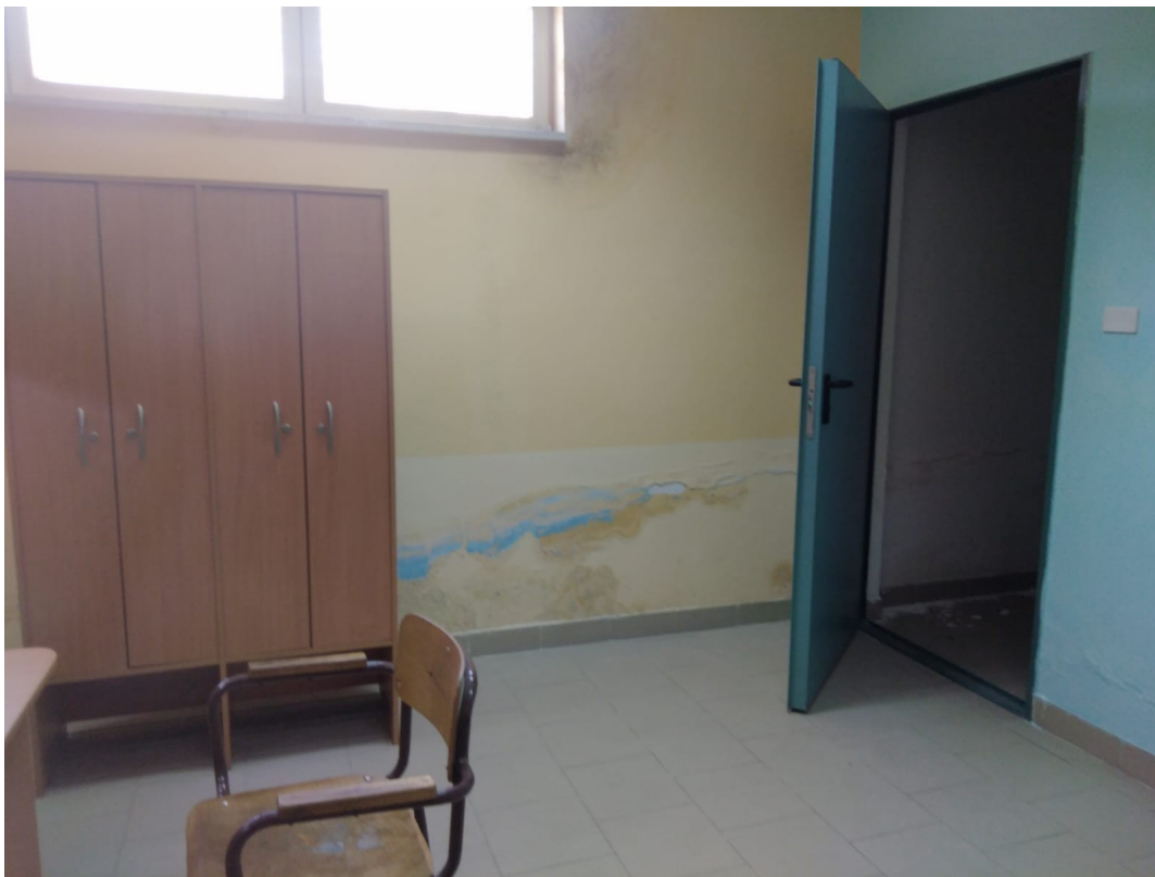
Figura 4: parete del locale spogliatoio
