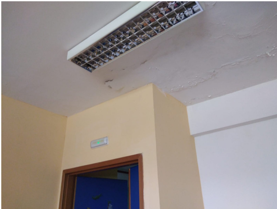
Figura 9: solaio del locale psico motorio
