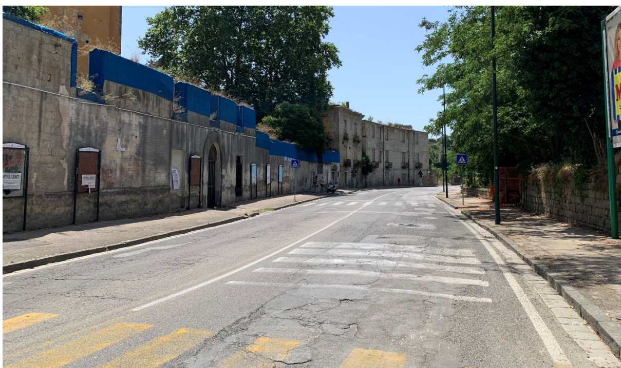
FOTO 2 - percorso ciclabile bidirezionale lato sx direzione Napoli
