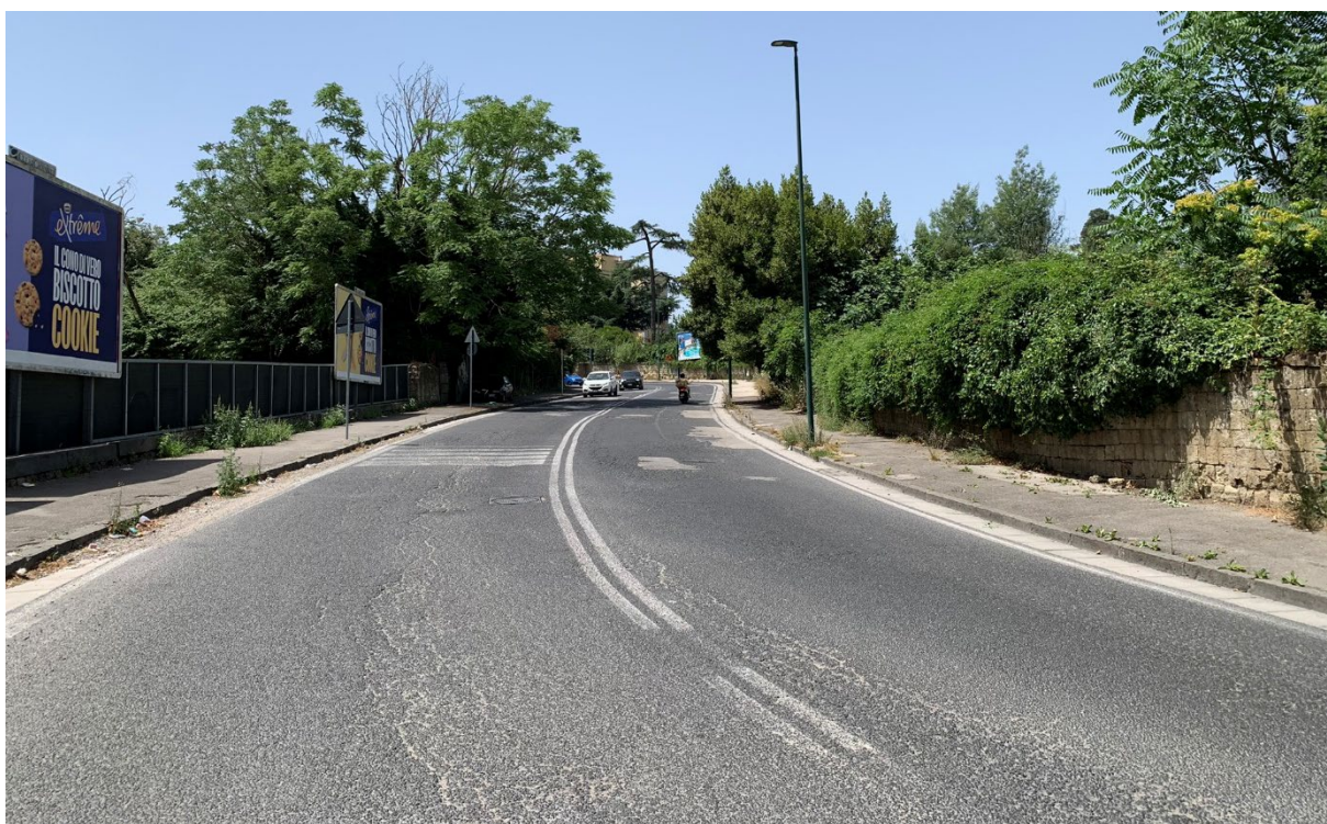
FOTO 6 - percorso ciclabile bidirezionale lato sx direzione Napoli
