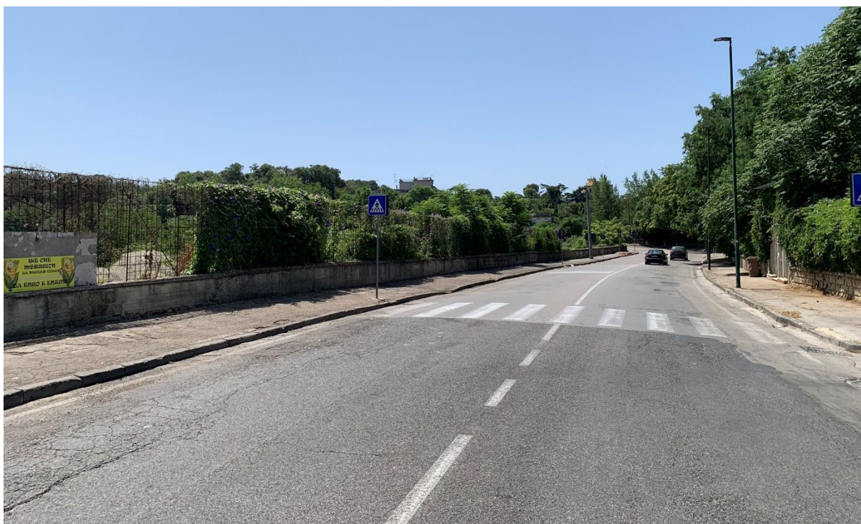
FOTO 3 - percorso ciclabile bidirezionale lato sx direzione Napoli
