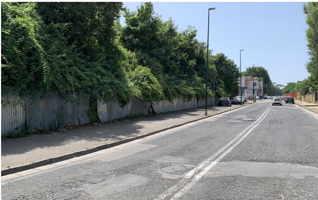
FOTO 7 - percorso ciclabile bidirezionale lato sx direzione Napoli
