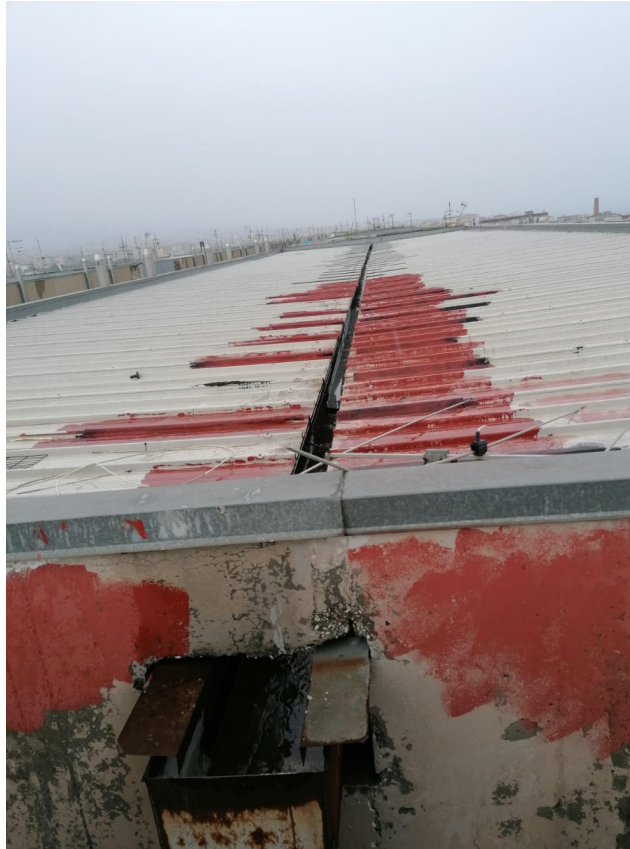
6. Copertura lamiera ondulata e canale di scolo in lamiera
