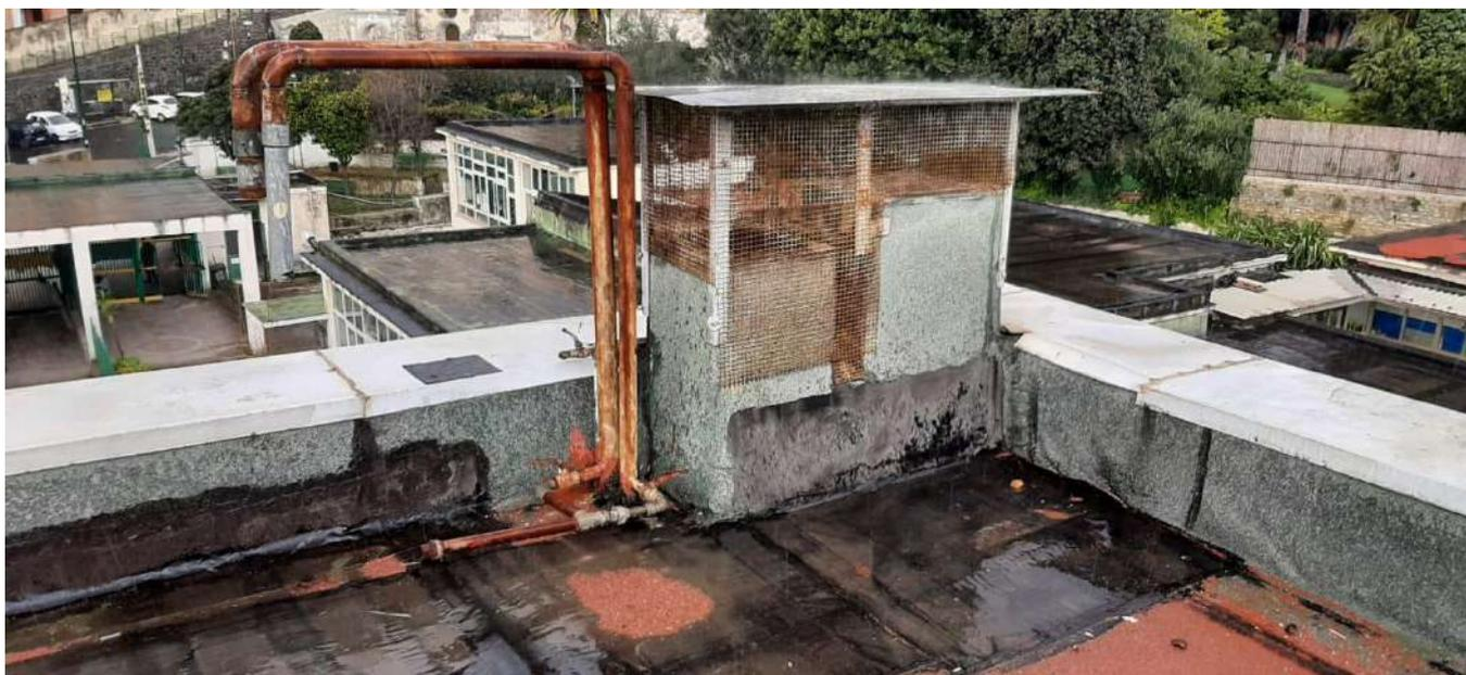
*foto n.6 Stato di fatto – Particolare dell’ammaloramento dello strato di guaina ardesiata e del ristagno d’acqua in prossimità dell’attacco solaio – muretto*
