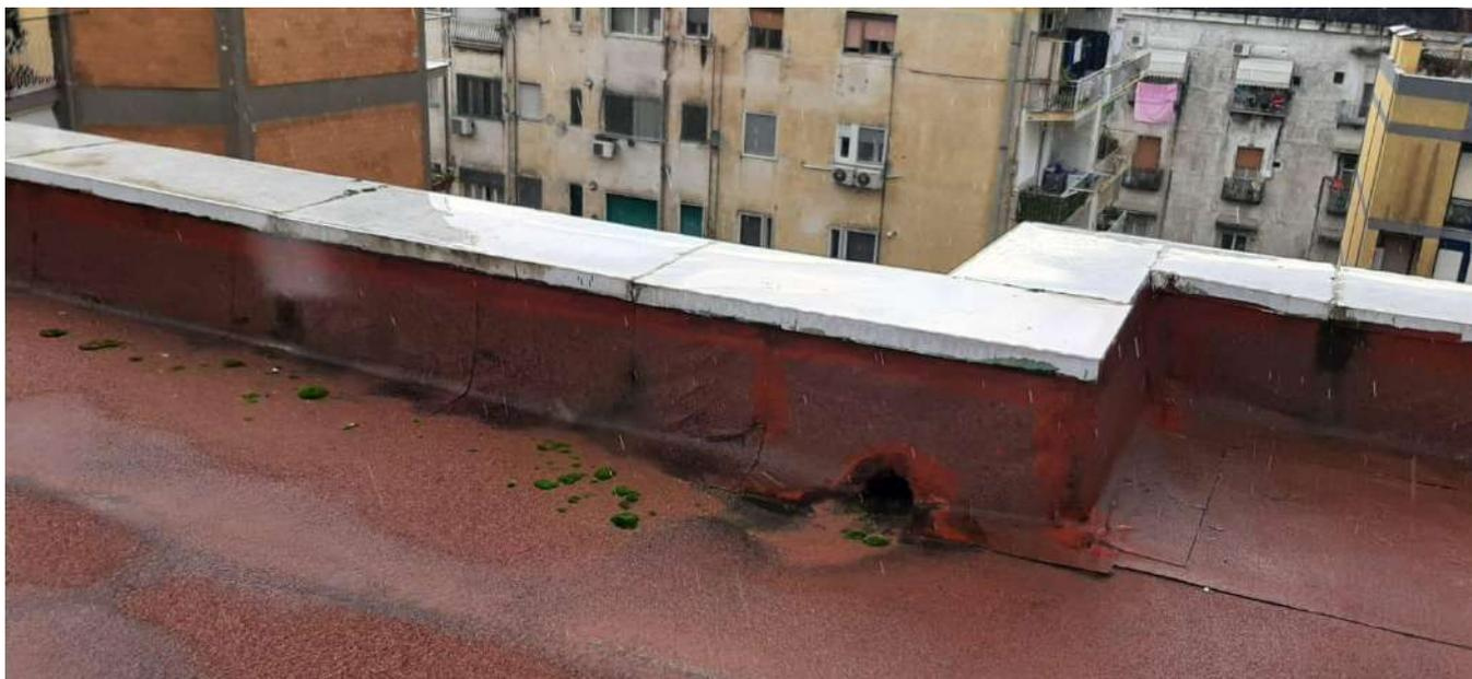
*foto n.4 Stato di fatto -Copertura dell'edificio scolastico – particolare dell'attacco del bocchettone di scolo della pluviale*
