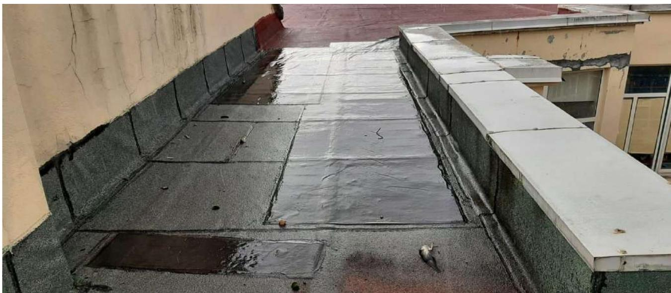
*foto n.8 Stato di fatto – Particolare criticità in prossimità del torrino scala e del rappezzo di guaina*
