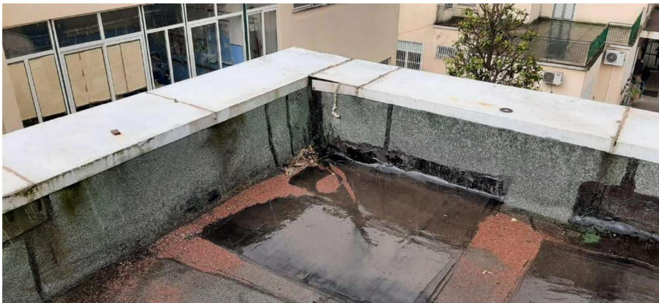
*foto n.5 Stato di fatto – Particolare dell’ammaloramento dello strato di guaina ardesiata e del ristagno d’acqua*
