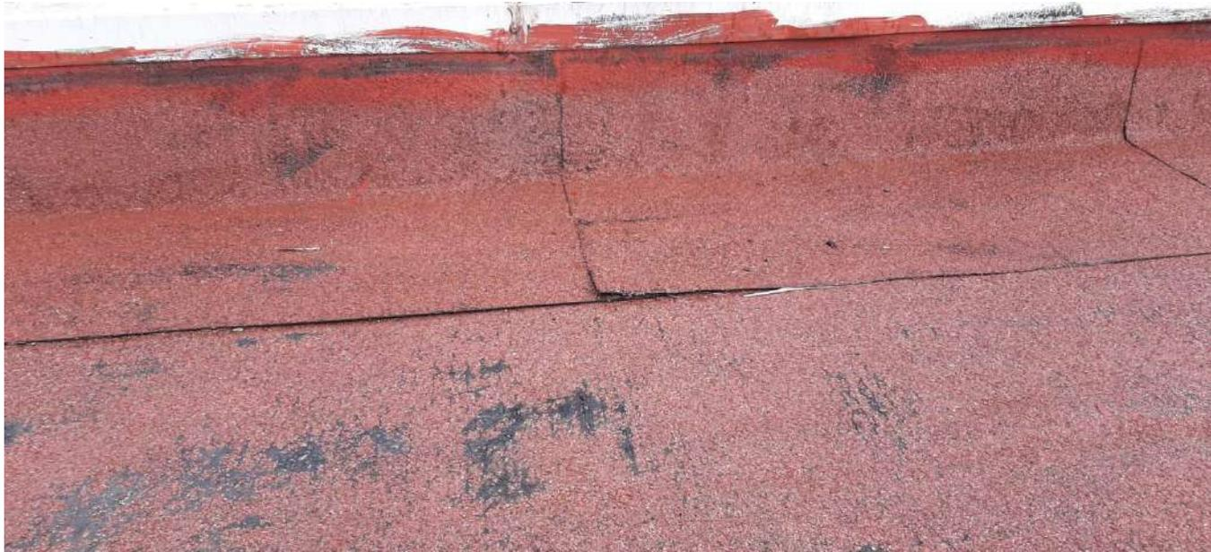
*foto n.7 Stato di fatto - Particolare dell'ammaloramento dello strato di guaina ardesiata e della posa in opera dei fogli in prossimità dell'attacco solaio – muretto*
