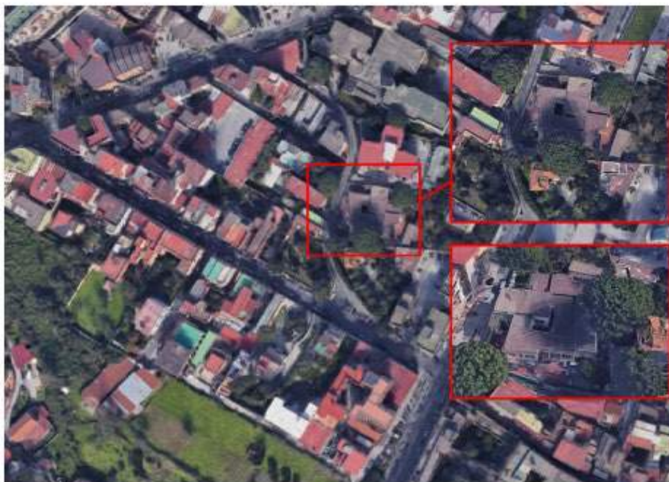
Figura 1 – Inquadramento dell’edificio oggetto di indagine e verifica sismica
