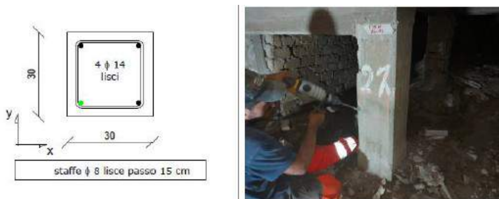
Figura 5: Saggio pilastro P 39 – piano interrato
