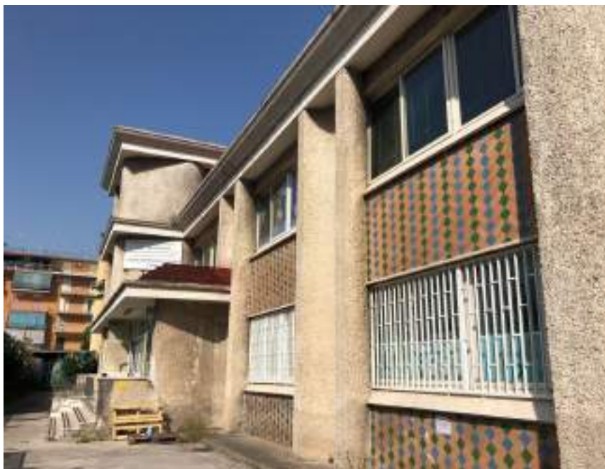
Figura 3– Prospetto sud-ovest (ingresso)
