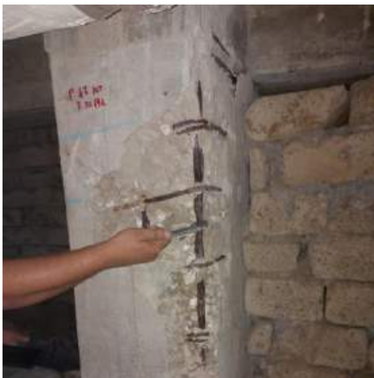
Figura 14 - Saggio pilastro 47 – I impalcato
