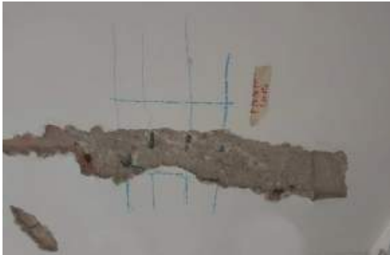
Figura 16 – Pacometria Trave P 25-36 – III impalcato
