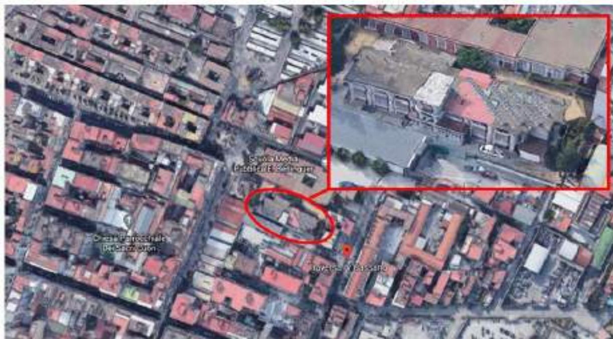
Figura 1: inquadramento edificio oggetto delle indagini
