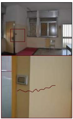
corrispondenza dell'aggancio al dell'attacco della tamponatura al corrispondenza dell'aggancio al tamponatura con possibile caduta dell'attacco della muratura al in fase di sisma.
