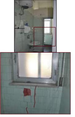
15\_Distacchi delle piastrelle di rivestimento con possibile caduta in fase di sisma.
