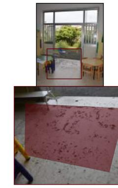
12\_Degrado delle piastrelle della pavimentazione di un'aula.
