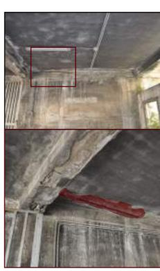
del solaio che rende visibile lo distacco della malta di intradosso corrispondeza della trave. del solaio che rende visibile lo strato di laterizi sottostante.
