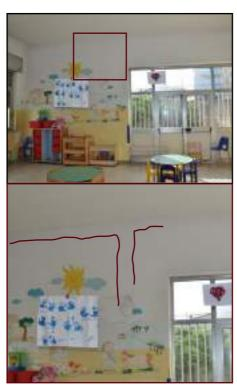
11\_Mancata adesione della muratura ai telai strutturali con possibile caduta in fase di sisma.
