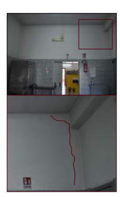
16\_Distacchi della muratura interna in corrispondenza dell'aggancio al telaio strutturale.
