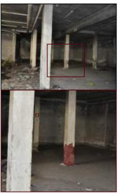
porzione inferiore di un pilastro ammaloramento del solaio in isolato.
