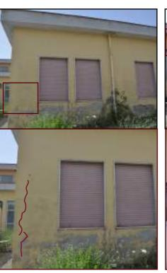
6\_Mancata adesione delle tampo- 7\_Caduta dello strato di finitura 8\_Microlesioni dovute alla man- 9\_Distacchi della muratura in 10\_Lesioni con conseguente esfocata adesione delle tamponature corrispondenza dell'aggancio al liazione dello strato di finitura. ai telai strutturali con possibile telaio strutturale. caduta in fase di sisma.
