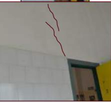
6\_Mancata adesione delle tampo- 7\_Mancata adesione delle tampo- 8\_Lesioni in corrispondenza nature interne ai telai strutturali nature interne ai telai strutturali dell'attacco della muratura al con possibile caduta in fase di con possibile caduta in fase di telaio strutturale. sisma.
