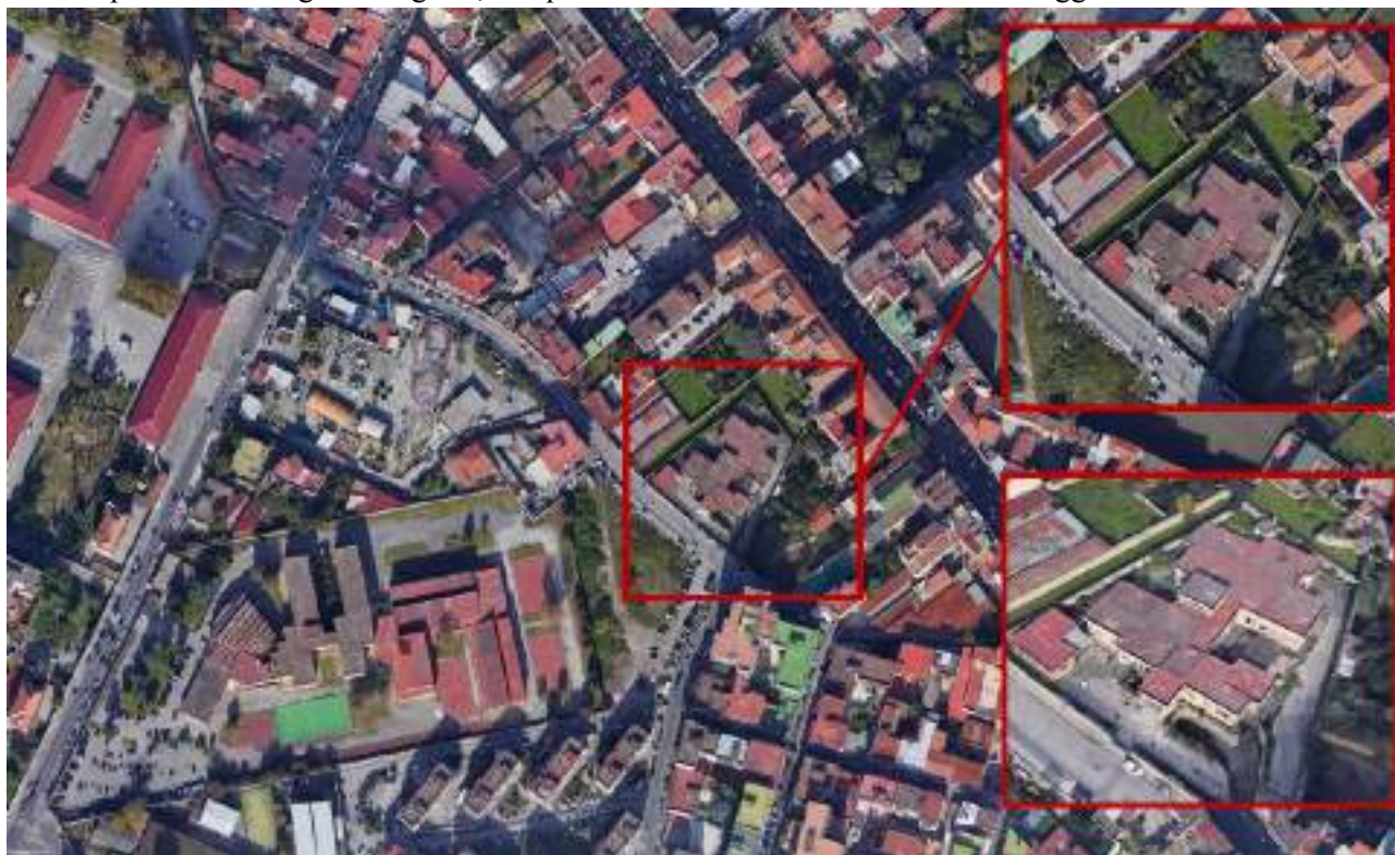
Figura 1 – Inquadramento dell'edificio oggetto di indagine e verifica sismica
