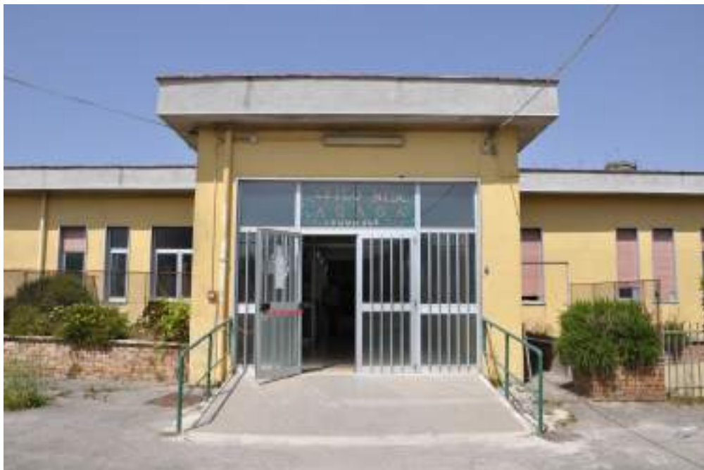
Figura 4 - Prospetto esterno sud-ovest (ingresso)
