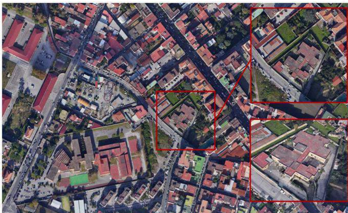
Figura 1: inquadramento edificio oggetto delle indagini
