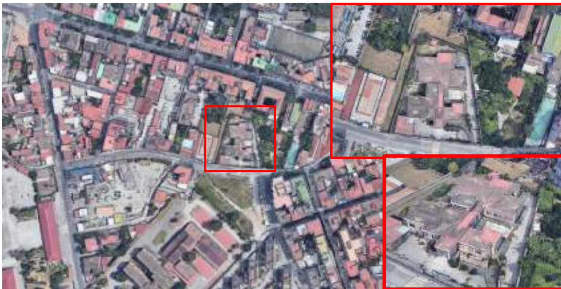
Figura 1 – Inquadramento dell'edificio oggetto di indagine e verifica sismica
