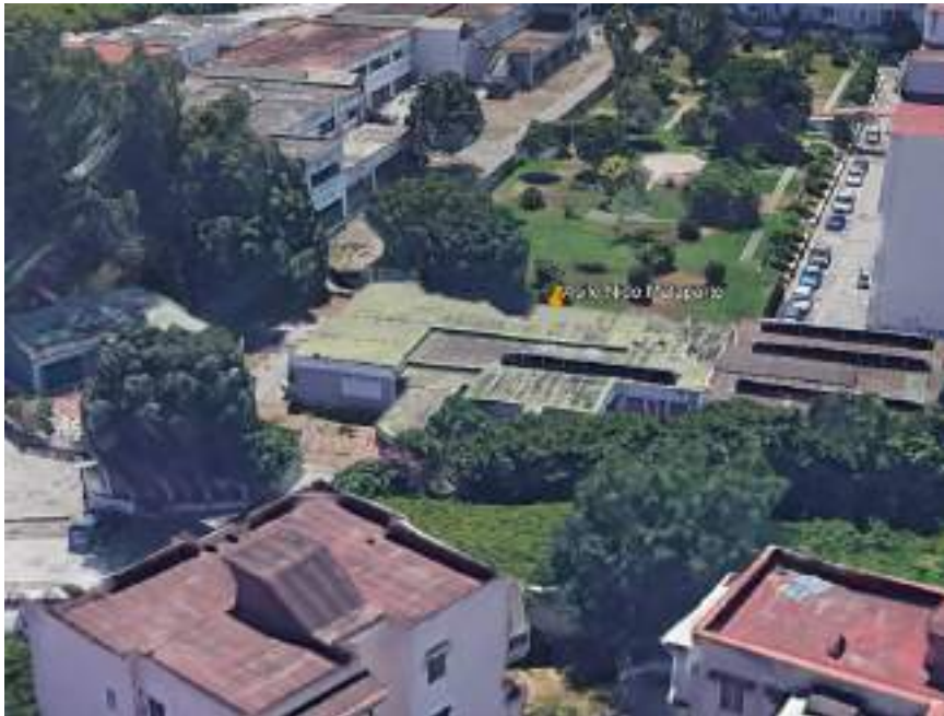
Figura 1 - Localizzazione geografica del fabbricato
