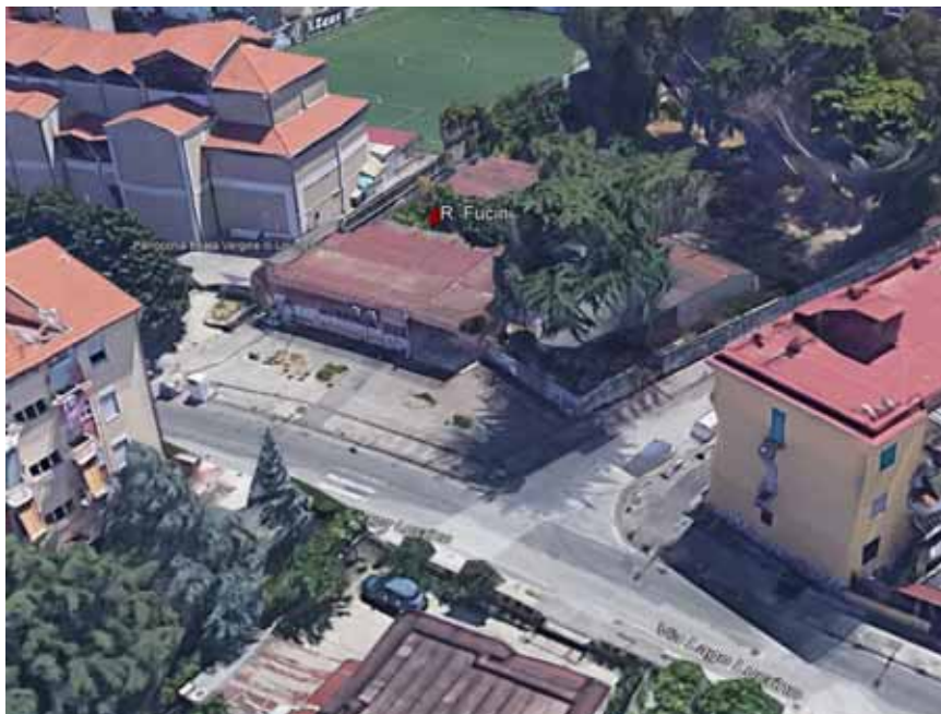
Figura 1 - Localizzazione geografica del fabbricato
