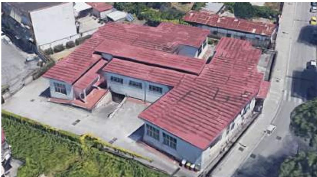
Figura 2 - Localizzazione geografica del fabbricato
