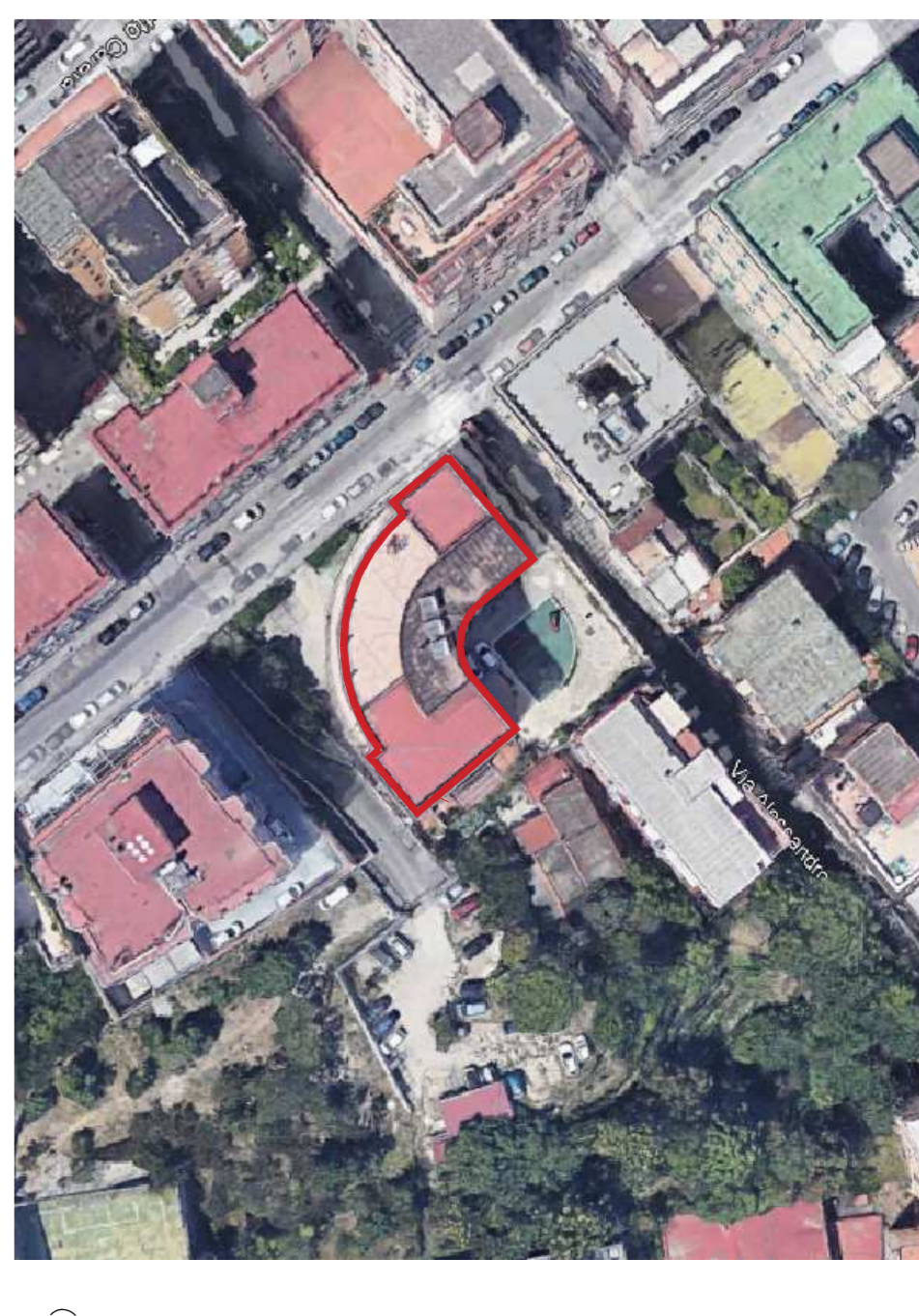
Edificio oggetto di verifica
