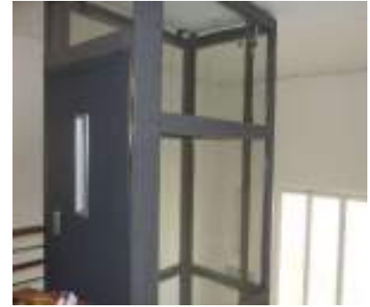
Chiusure del castelletto ascensore
