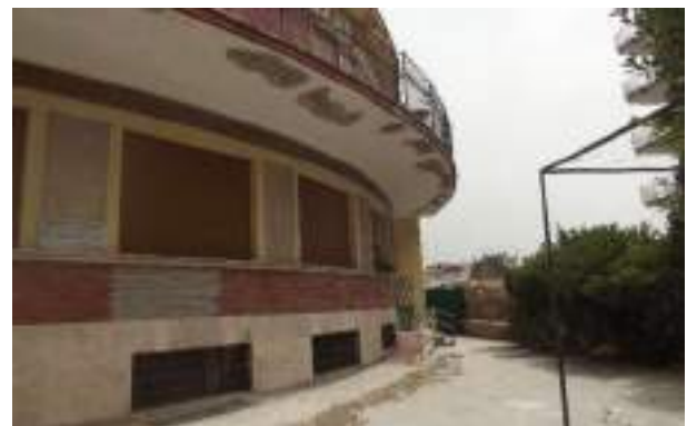
Rivestimenti di facciata distaccati (a sinistra) e ripristinati (a destra)
