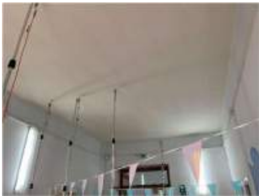
Estratto dalla Relazione Tecnica sulle indagini sui solai: Strumentazione di misura – Piano rialzato
