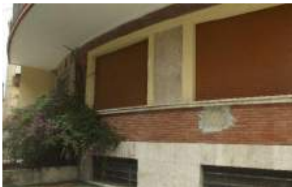
Rivestimenti di facciata distaccati (a sinistra) e ripristinati (a destra)
