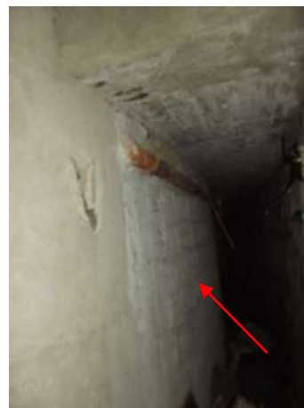
Ispezione visiva: muratura di tufo perimetrale
