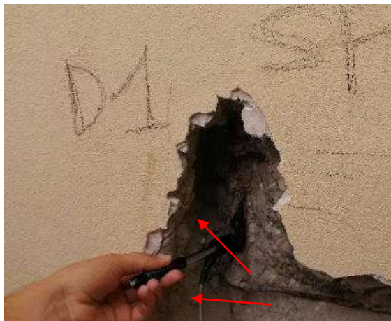
Prova durometrica D1 al piano seminterrato: muratura di tufo perimetrale ai lati del pilastro
