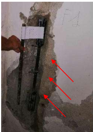
Prelevio di barra F1 al piano seminterrato: muratura di tufo perimetrale ai lati del pilastro
