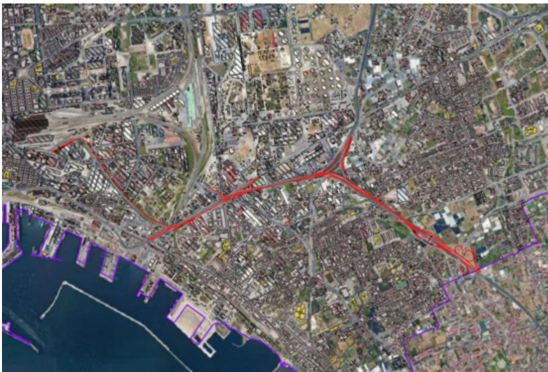
Figura 8 – Infrastrutture di pertinenza di Autostrade Meridionali S.p.A.
