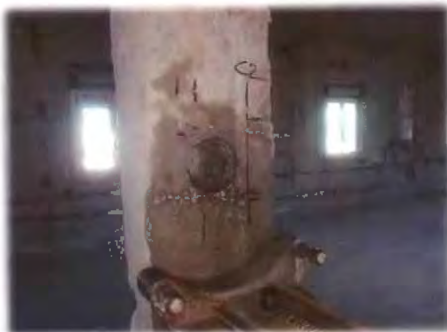
Prelievo del campione di calcestruzzo C2
