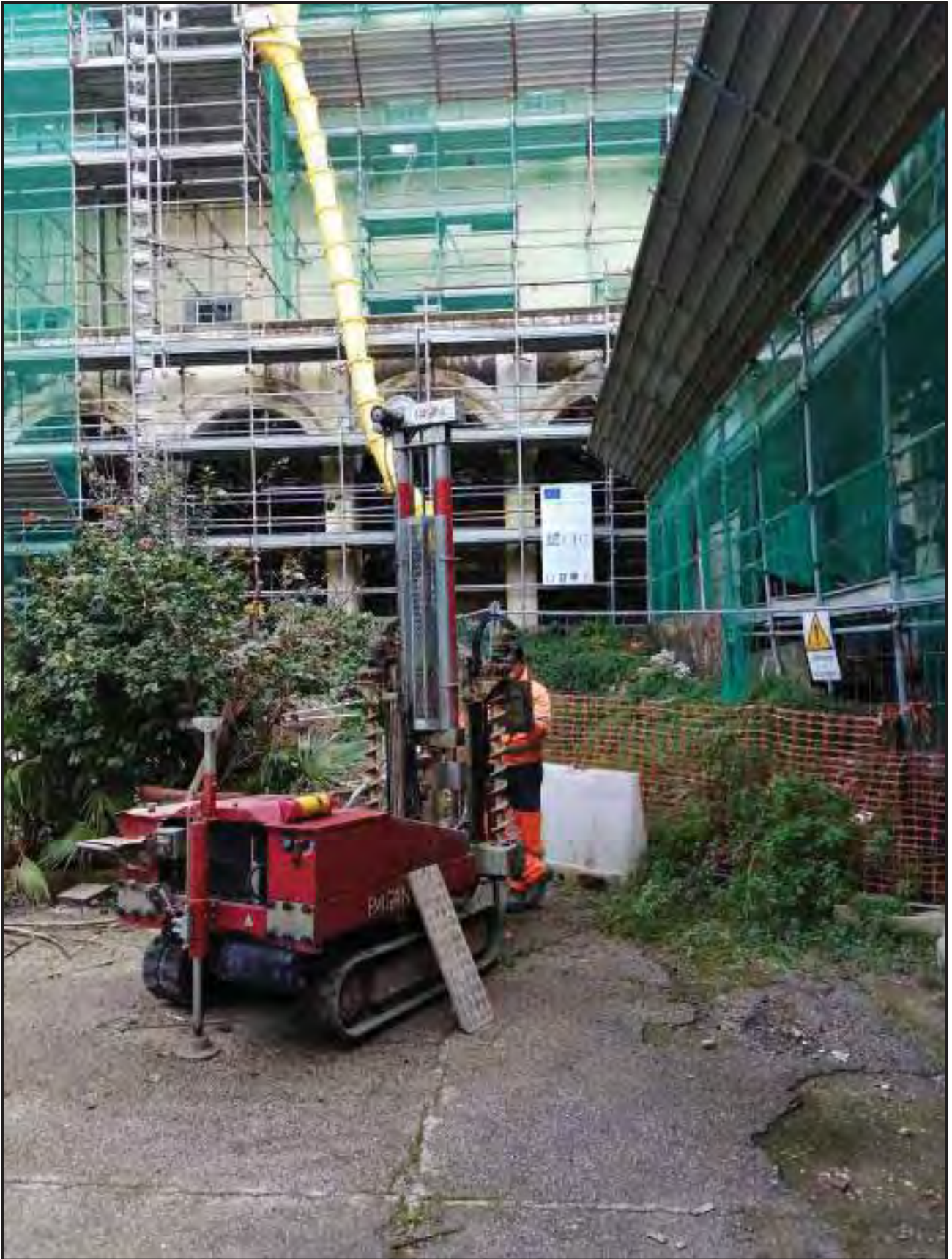
Prove penetrometriche dinamiche pesanti (D.P.S.H.)
