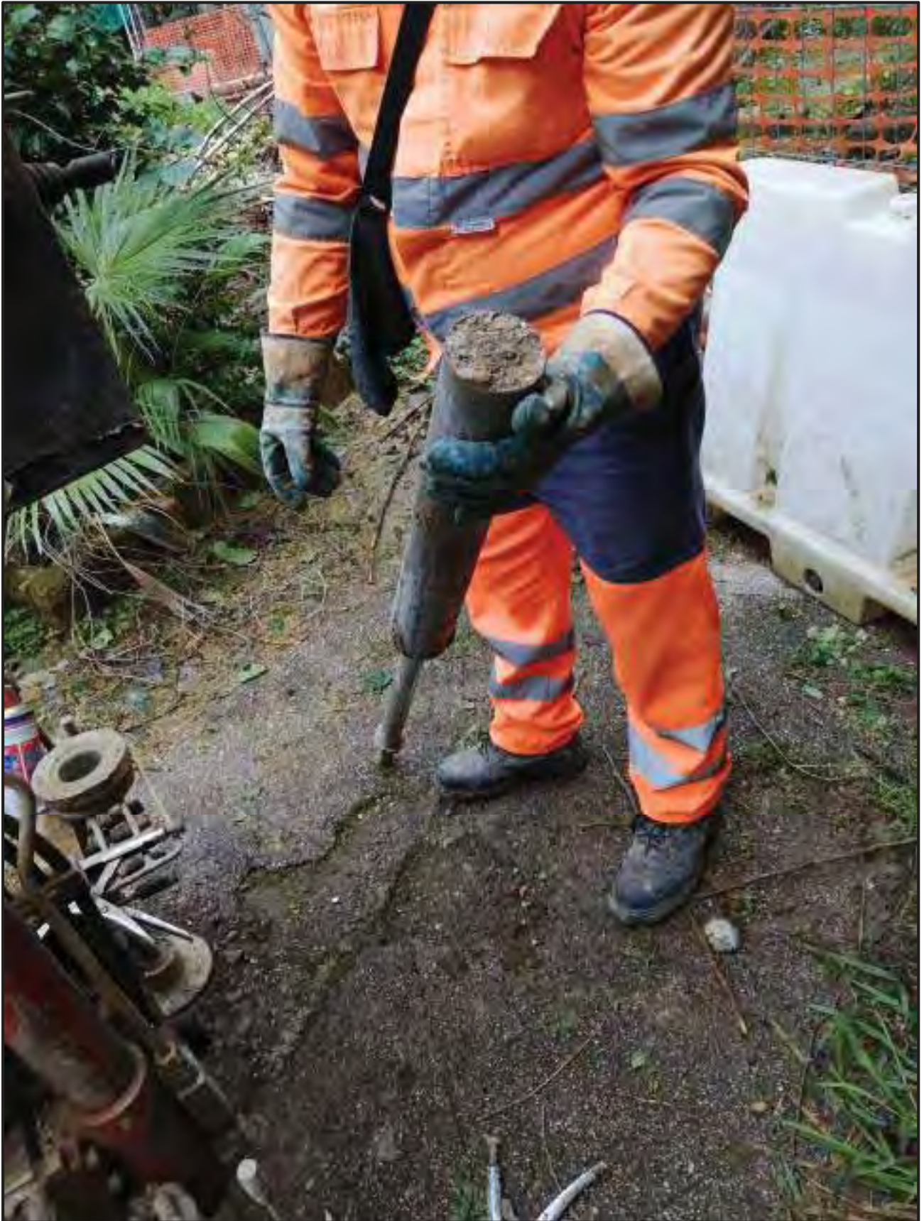
Prelievo campione indisturbato per prove geotecniche di Laboratorio
