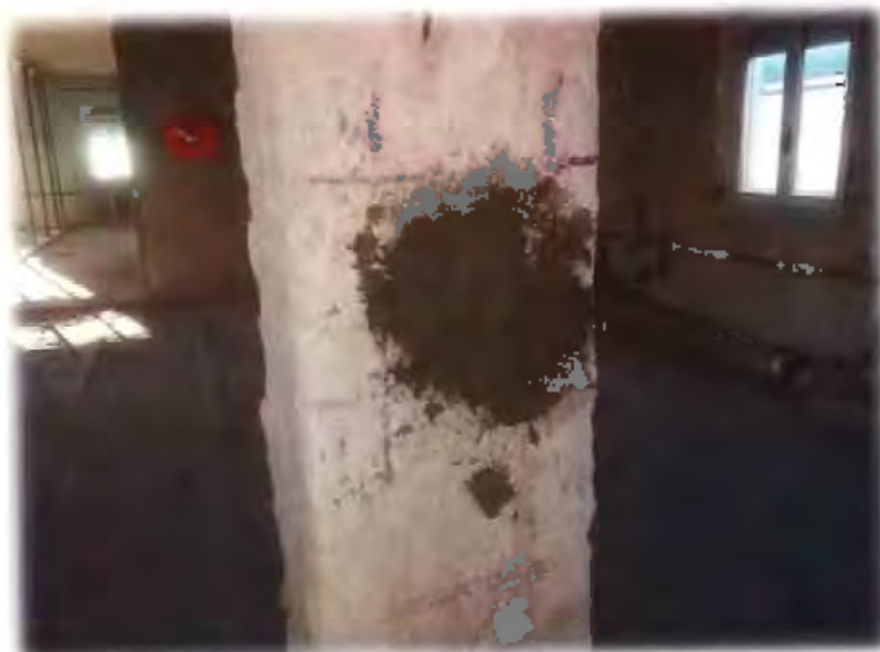
Ripristino strutturale del carotaggio C1
