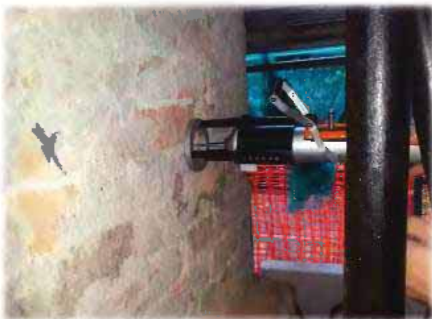
Esecuzione delle prove penetrometriche su malta
