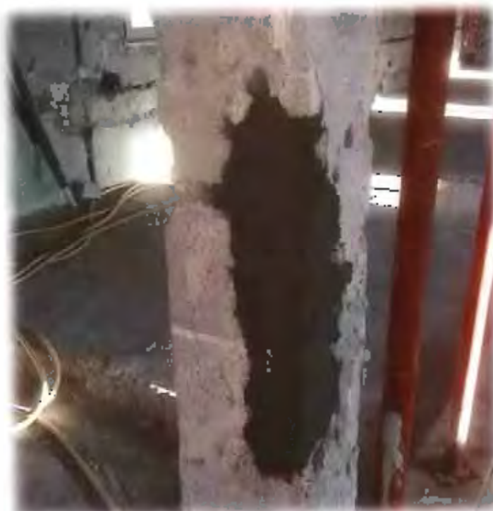
Ripristino strutturale del prelievo di acciaio
