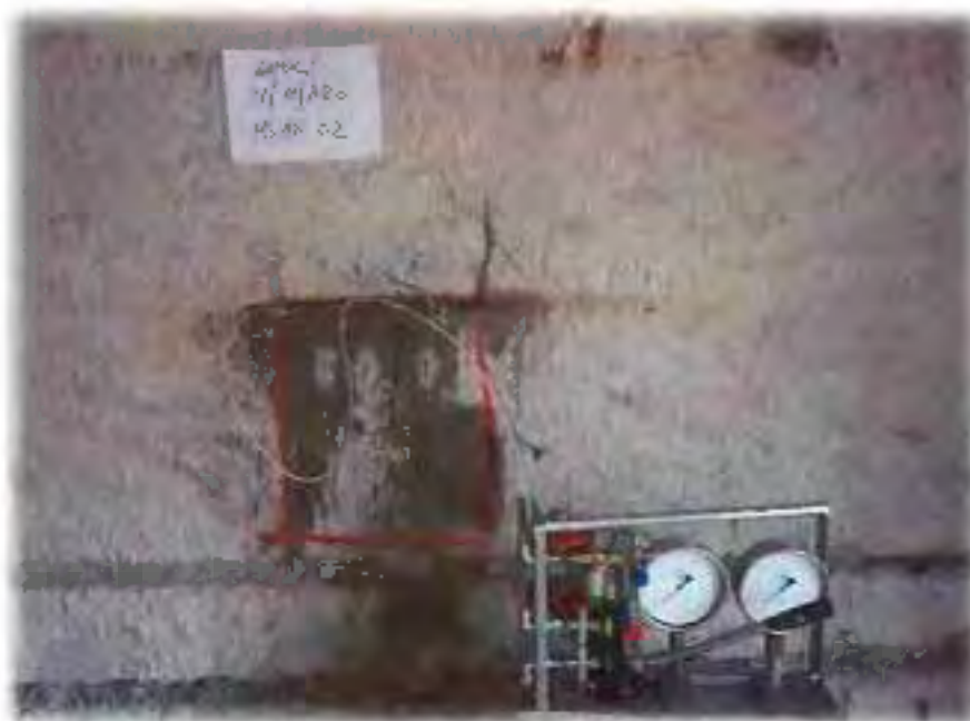
Esecuzione della prova con martinetto singolo
