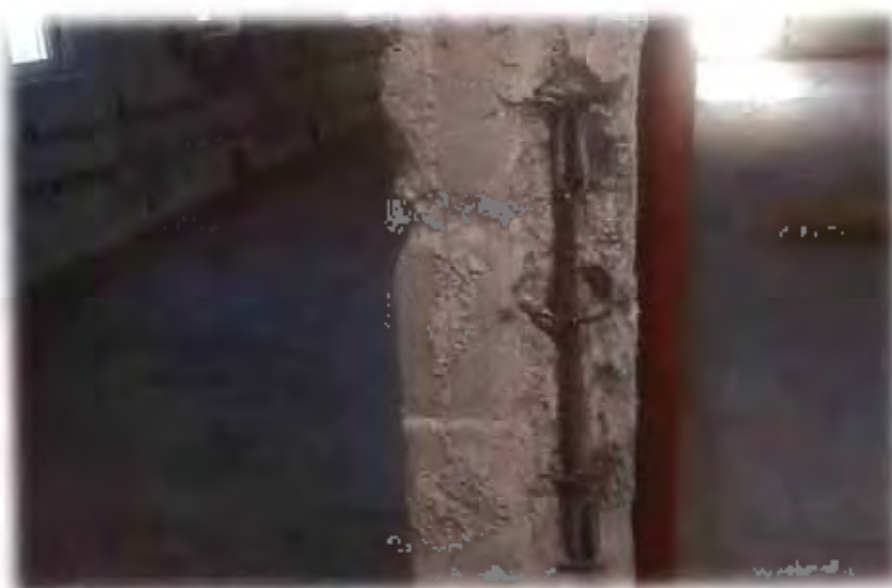
Prelievo del campione di acciaio – ripristino della continuità dell'armatura
