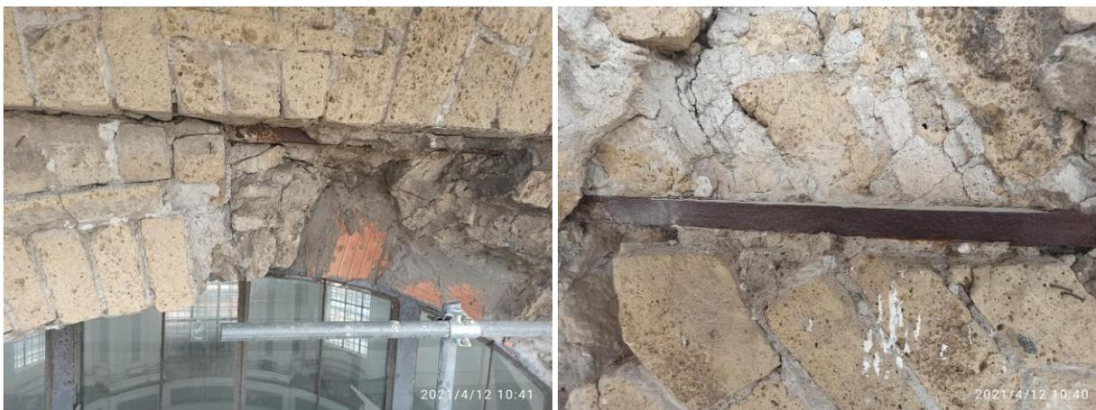
Foto 1 e 2. Vista del cerchiaggio metallico inferiore (dettaglio)
