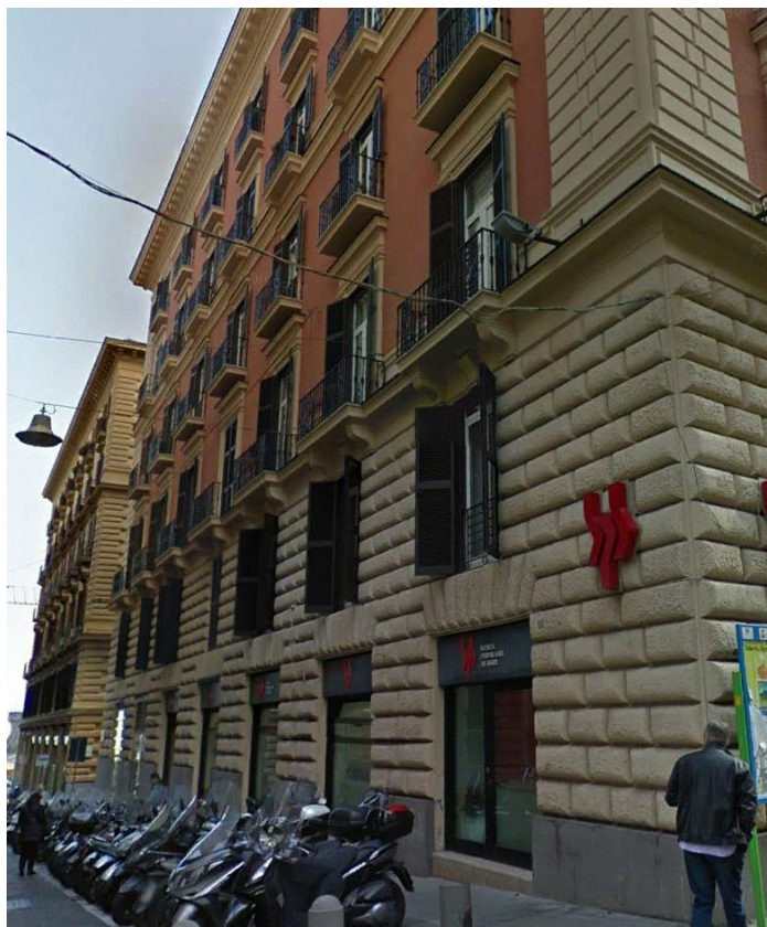
Figura 6-4. N°3 - Prospetto su via Pisanelli.
