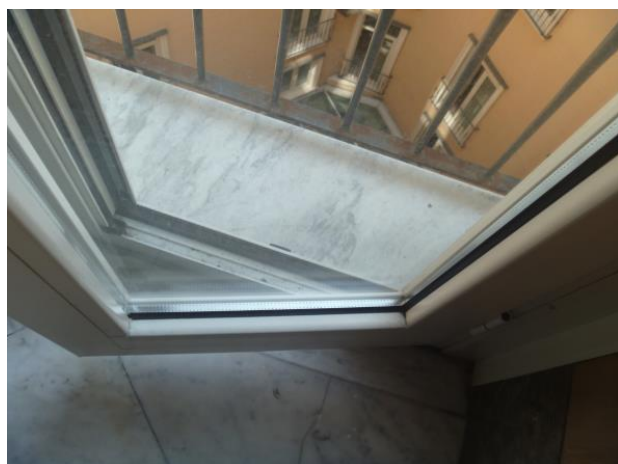
Figura 5-7. Particolare dei serramenti.
