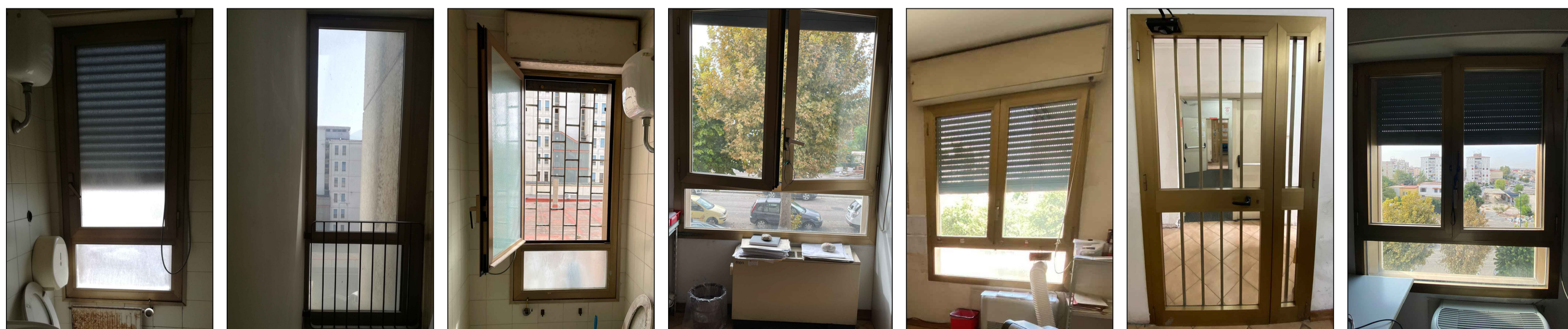
Rilievo fotografico degli infissi ed oscuranti con telaio in alluminio anodizzato e vetro singolo
