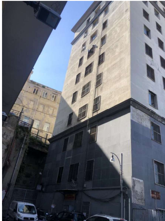
Figura 1- Ingresso su Via Foria
