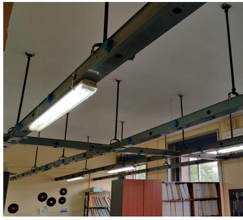
Il corpo illuminante individuato è costituito da un sistema singolo o a fila continua per installazione a plafone, parete, sospensione o per installazione ad incasso a rasamento in controsoffitto in cartongesso.
