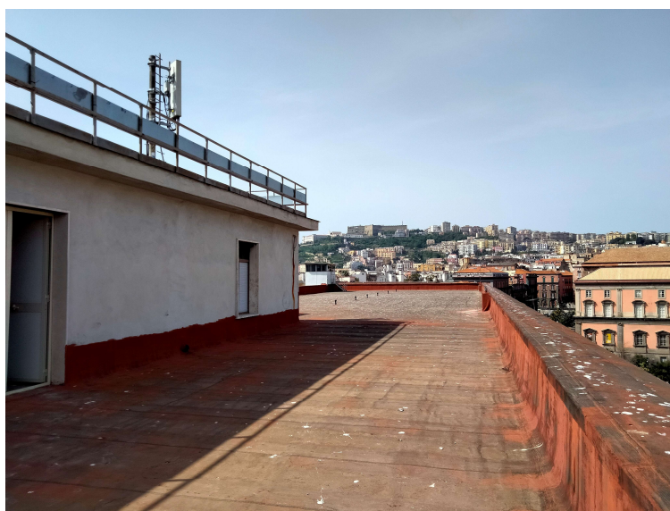
Figura 1 Parete per alloggiamento dispositivi elettrici
