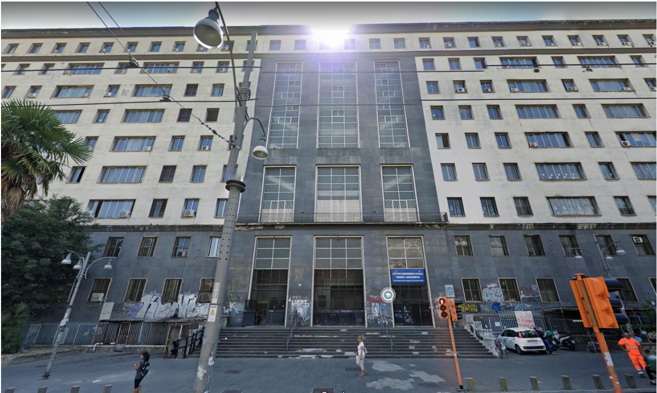
Figura 6 – Esterno della struttura
