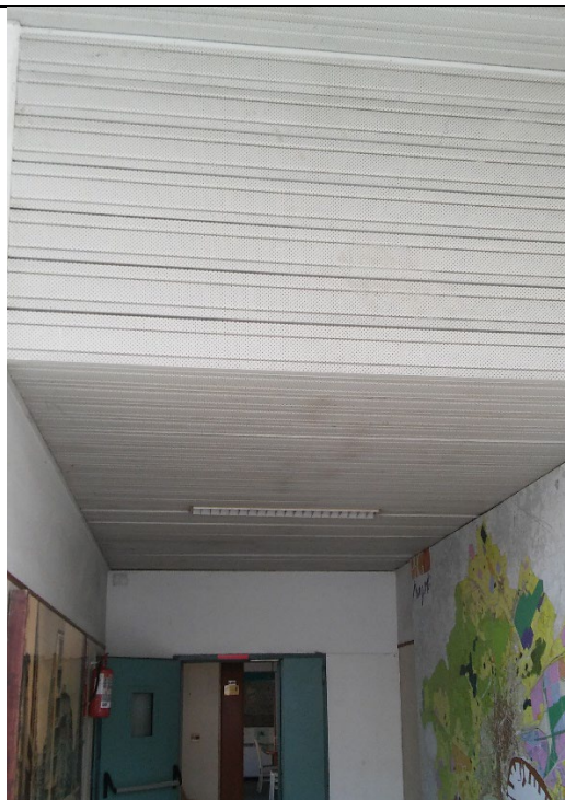
Dettaglio della controsoffittatura
