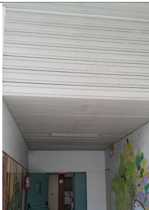
Dettaglio della controsoffittatura
